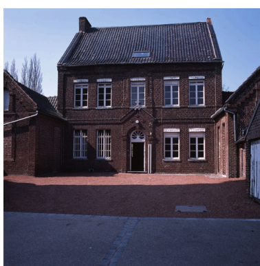
Vue générale depuis la place Sadi-Carnot. Phot. Pierre Thibaut IVR31_20095902004XA
