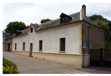
Ferme, rue du 8-mai-1945, reconstruite au milieu du 19e siècle. Phot. Bertrand Fournier IVR22_20098005126NUCA
