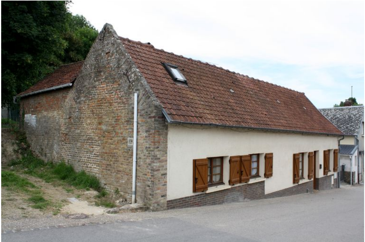
Maison, 10 rue du 8 mai 1945 (C 238)
