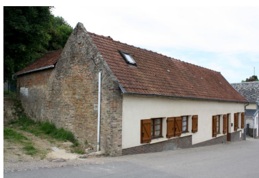
Maison, 10 rue du 8 mai 1945 (C 238) Phot. Bertrand Fournier IVR22_20098005143NUCA
