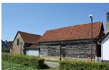
Ferme du début du 19e siècle avec grange sur rue recouverte d'un essentage de planches, rue de la Voie.
