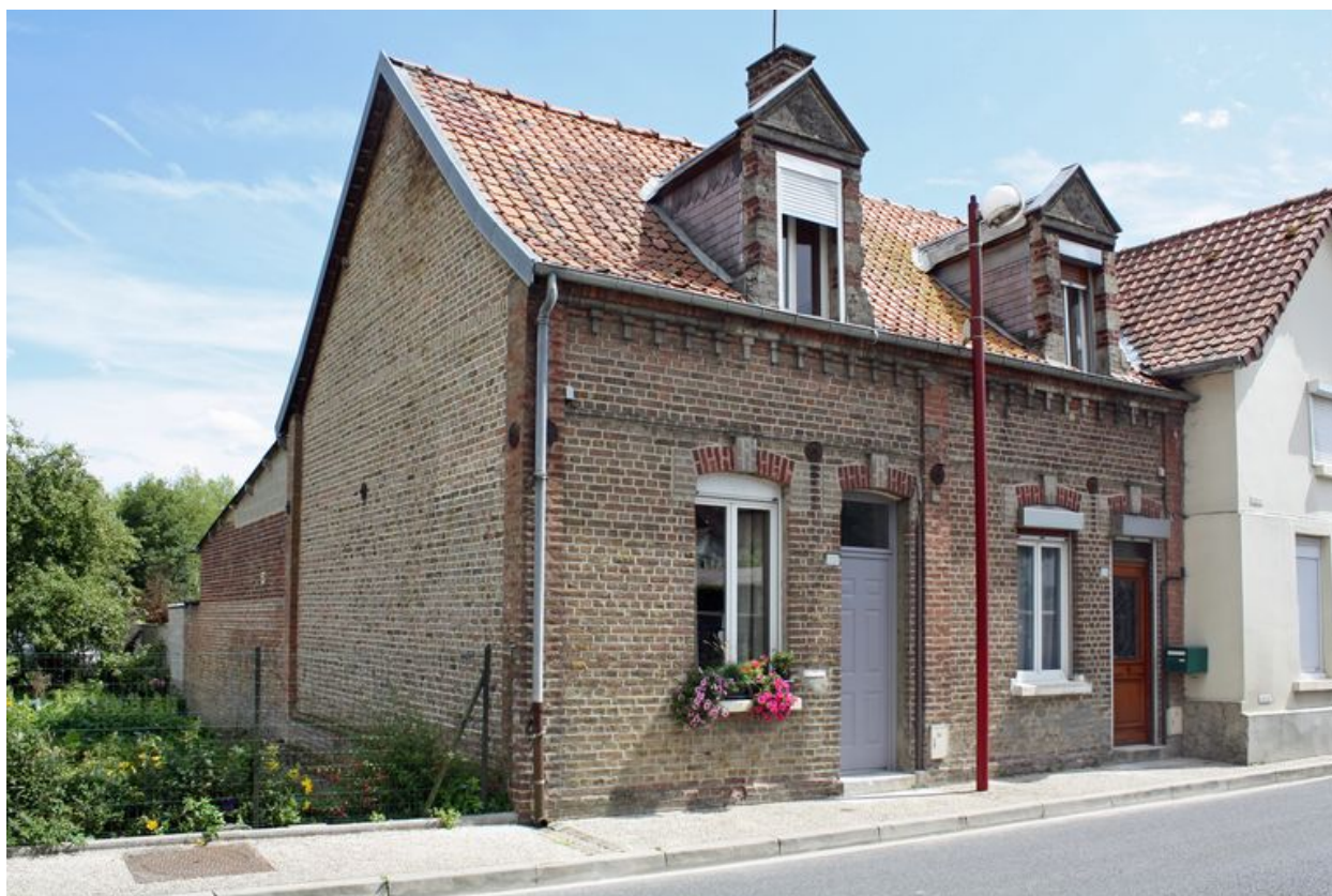
Maison de rapport à deux unités d'habitation, 18 et 20, rue Georges-Outrebon (C 319-320).
