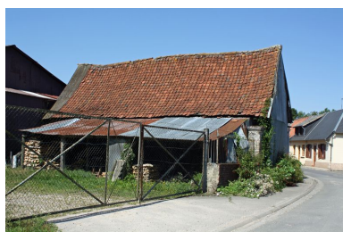
Grange du début du 19e siècle, rue Gambetta (C 197-200). Phot. Bertrand Fournier IVR22_20098005161NUCA
