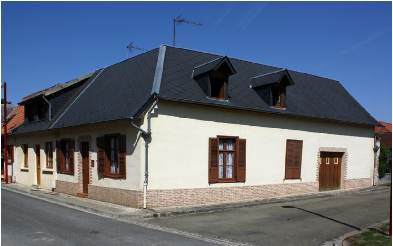
Ferme du début du 19e siècle, 3 rue Gambetta (C 330-331).
