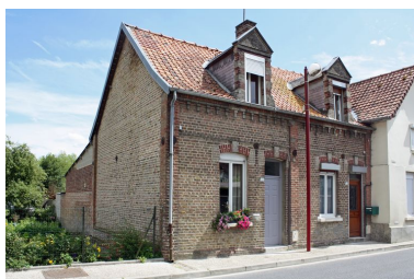
Maison de rapport à deux unités d'habitation, 18 et 20, rue Georges-Outrebon (C 319-320). Phot. Bertrand Fournier IVR22_20098005145NUCA
