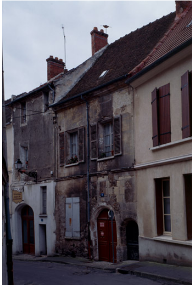
Elévation sur la rue. Phot. Thierry Lefébure IVR22_19930201898XA
