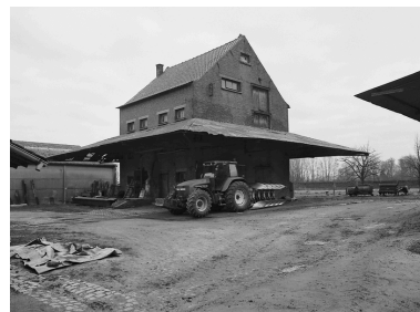
Ferme Fontenier- Willoquier, la brasserie. Phot. Philippe Dapvril IVR31_20045900063X
