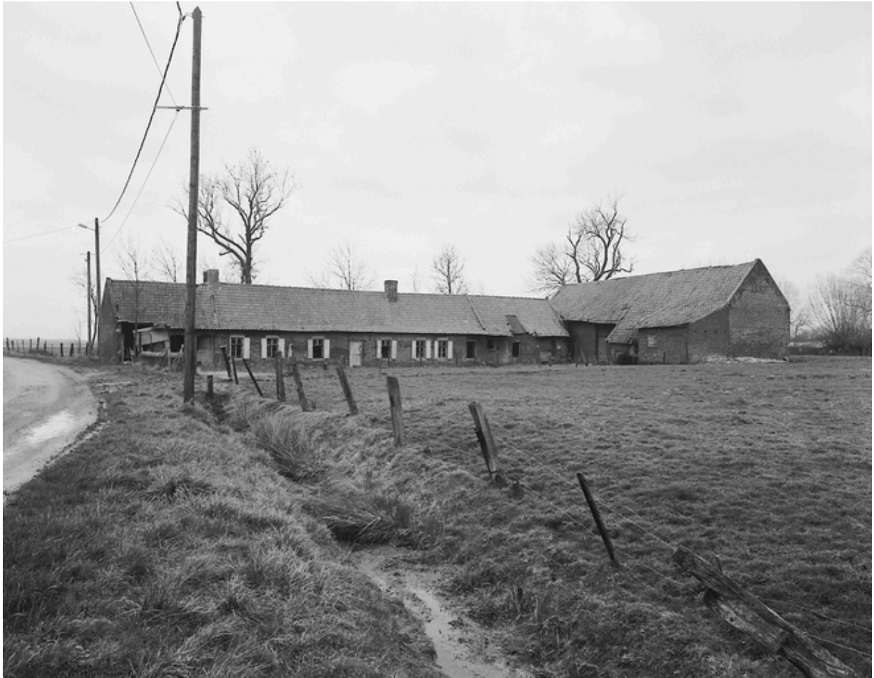
Ferme en L, rue du Faux.
