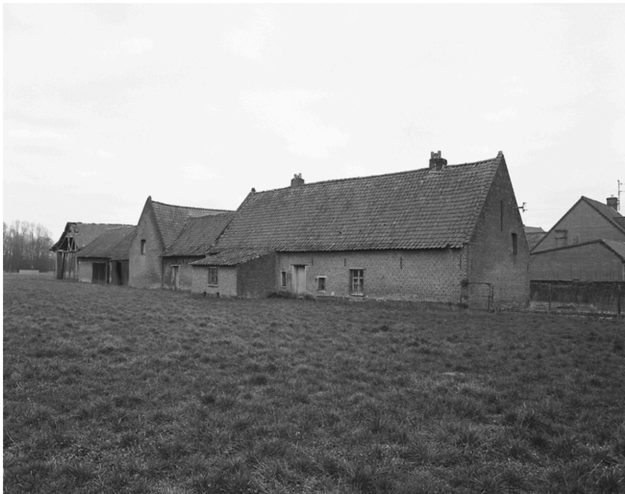
Ferme en F, rue de la Lombarderie, élévation postérieure.
