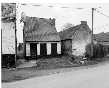
Maison d'ouvrier agricole, rue de la Lombarderie. Phot. Philippe Dapvril IVR31_20045900086X
