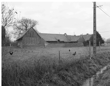
Ferme, rue du Faux, pan de bois dans le mur de la grange. Phot. Philippe Dapvril IVR31_20045900083X
