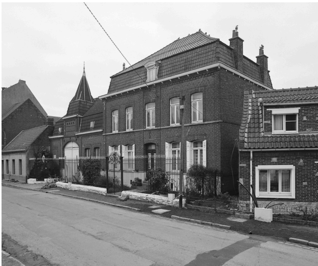
Ferme, 51-59, rue de l'Eglise.
