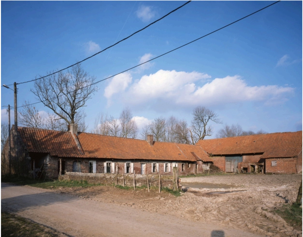
Ferme en L, rue du Faux.
