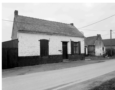
Maison d'ouvrier agricole, rue de la Lombarderie. Phot. Philippe Dapvril IVR31_20045900084X
