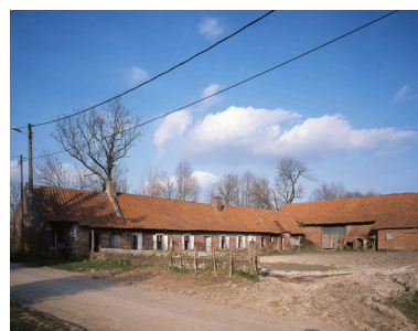
Ferme en L, rue du Faux. Phot. Pierre Thibaut IVR31_20095901338VA
