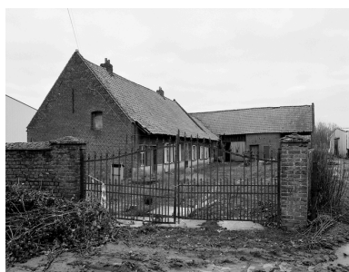
Ferme en F, rue de la Lombarderie. Phot. Philippe Dapvril IVR31_20045900064X
