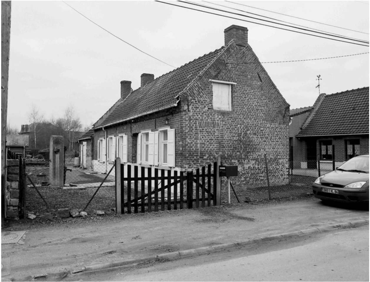
Maisons élémentaire, rue de la Lombarderie.
