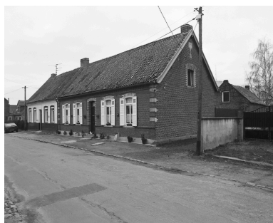
Maisons en alignement rue de la Chapelle. Phot. Philippe Dapvril IVR31_20045900078X
