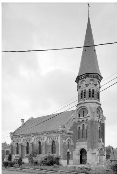
Elévation nord-ouest. Phot. Jean-Michel Perrin IVR22_19856000761X
