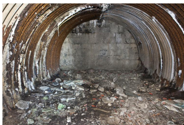
Une des deux salles de l'édifice Phot. Jean-Marc Ramette IVR31_20145904158NUCA
