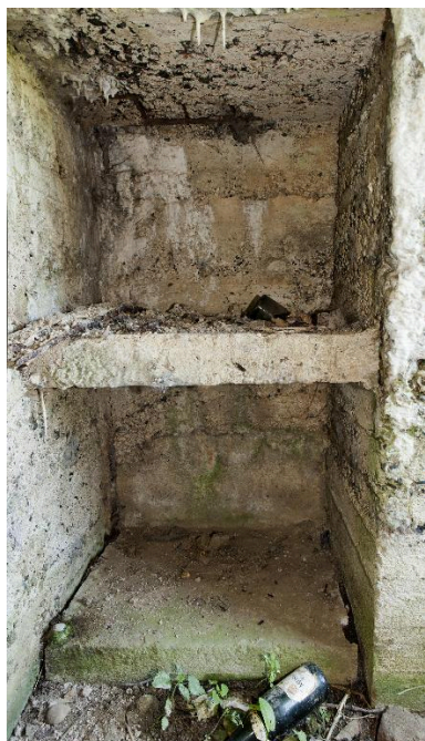
Resserres à mitrailleuses, entrée nord-est Phot. Jean-Marc Ramette IVR31_20145904159NUCA
