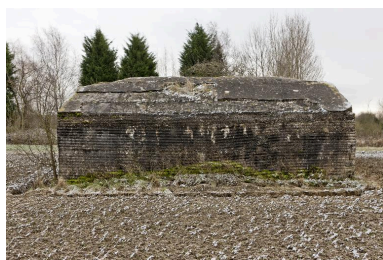
Élévation nord-ouest Phot. Jean-Marc Ramette IVR31_20145904171NUCA
