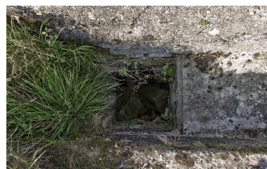
Accès à l'intérieur par échelons métalliques, depuis la tranchée surélevé Phot. Jean-Marc Ramette IVR31_20145904160NUCA
