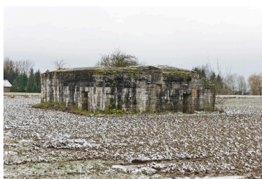
Vue vers l'ouest Phot. Jean-Marc Ramette IVR31_20145904166NUCA
