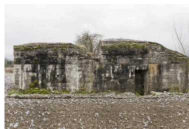
Entrée sur l'élévation nord-est. Phot. Jean-Marc Ramette IVR31_20145904173NUCA
