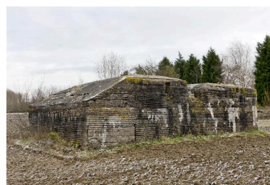
Vue vers l'est Phot. Jean-Marc Ramette IVR31_20145904170NUCA
