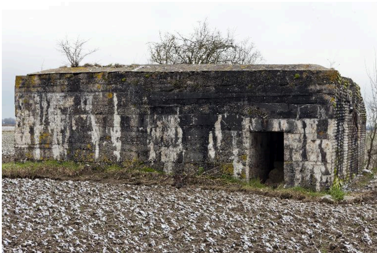
Vue vers l'ouest, entrée sud-est
