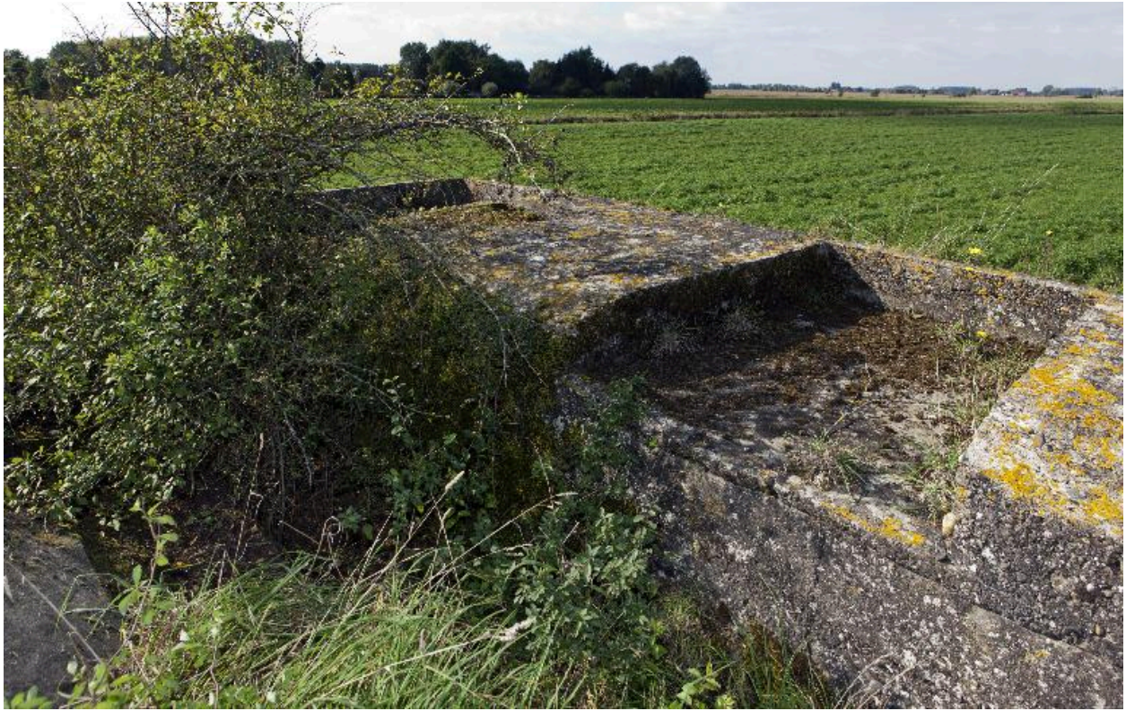
Depuis le couvrement, les deux emplacements de mitrailleuse
