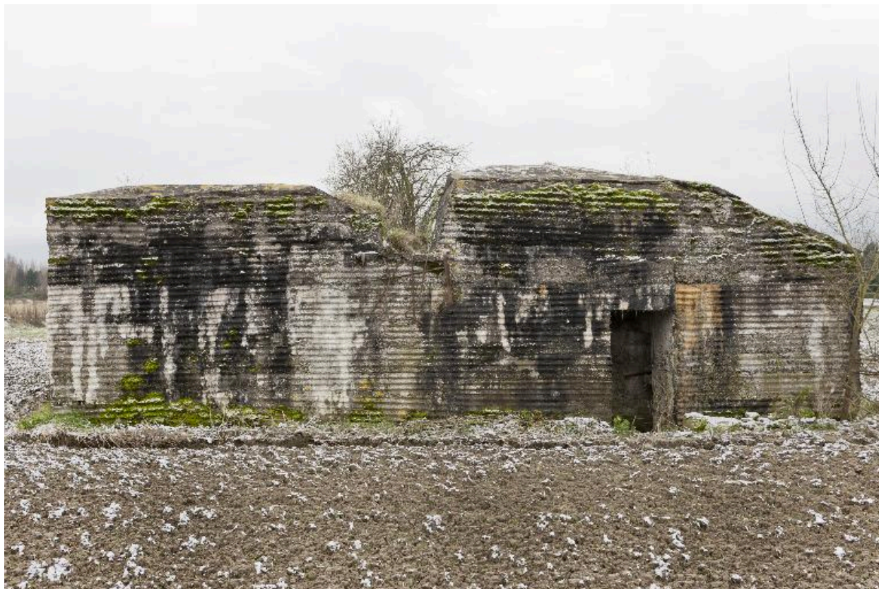
Entrée sur l'élévation nord-est.
