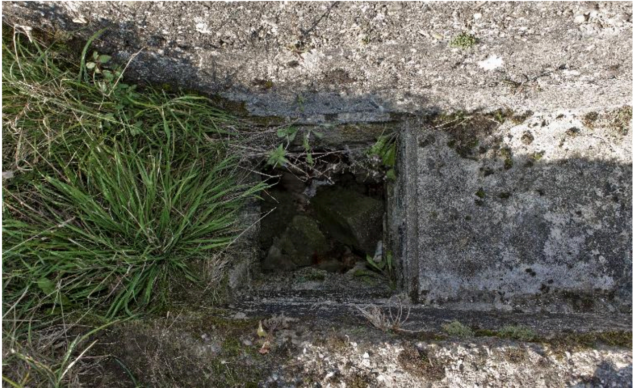
Accès à l'intérieur par échelons métalliques, depuis la tranchée surélevé
