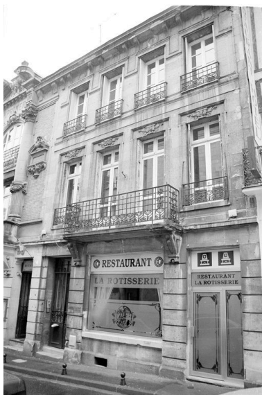
Façade sur rue : vue partielle. Phot. Bertrand Fournier IVR22_20016000022Z
