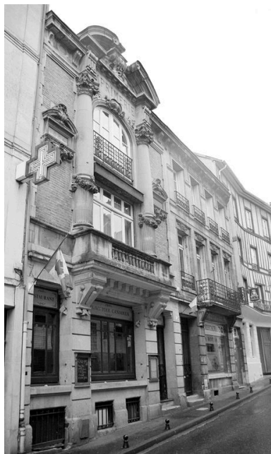
Façade sur rue. Phot. Bertrand Fournier IVR22_20016000015Z
