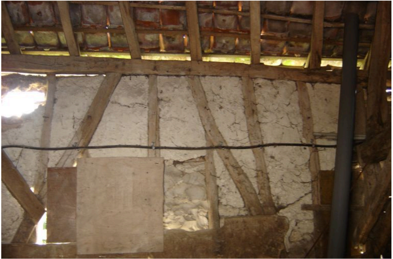
Vue intérieure permettant d'appréhender la composition des murs.
