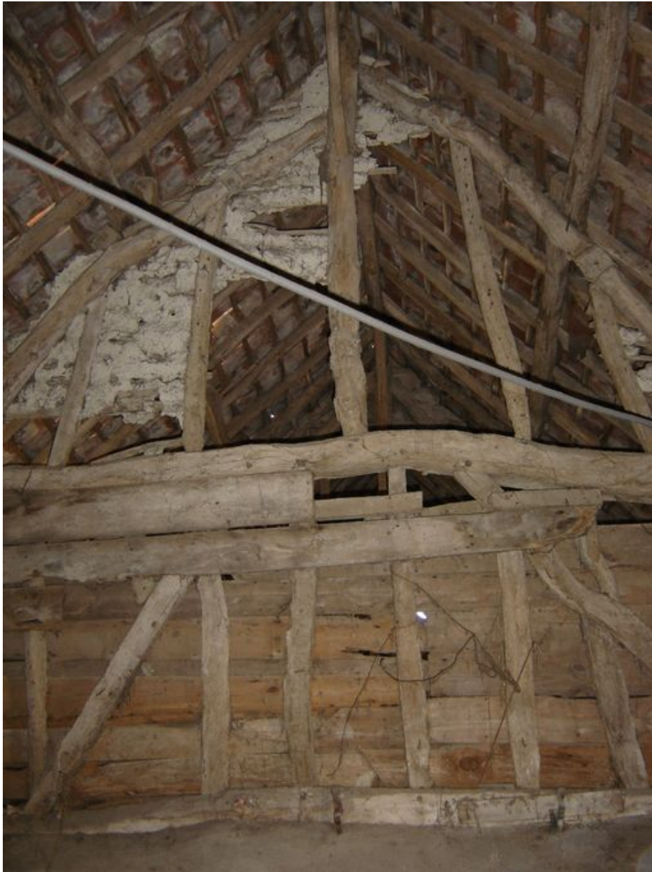
Détail de la charpente des bâtiments annexes.
