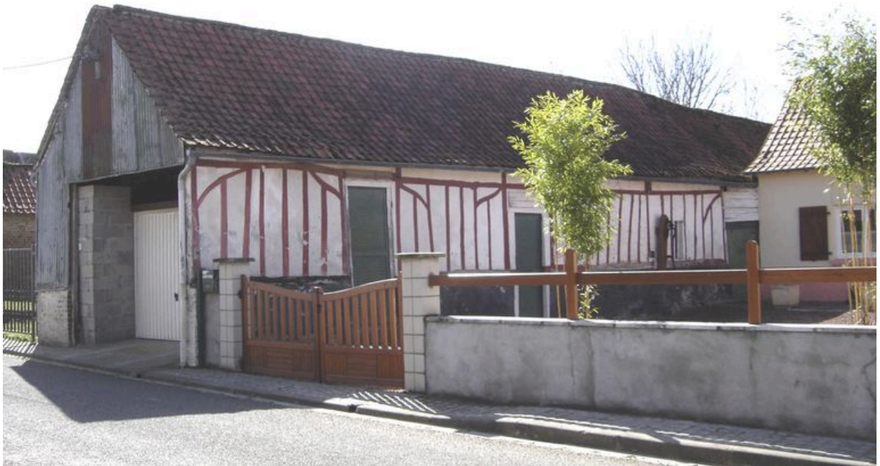
Vue des bâtiments situés à l'est de la propriété.
