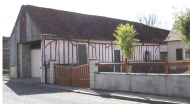
Vue des bâtiments situés à l'est de la propriété. Phot. Inès Guérin IVR22_20058005493NUCA
