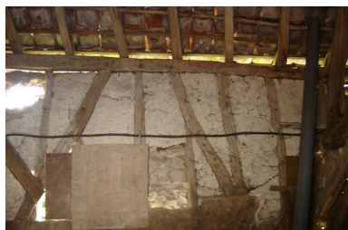
Vue intérieure permettant d'appréhender la composition des murs. Phot. Inès Guérin IVR22_20058005495NUCA
