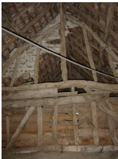
Détail de la charpente des bâtiments annexes. Phot. Inès Guérin IVR22_20058005496NUCA
