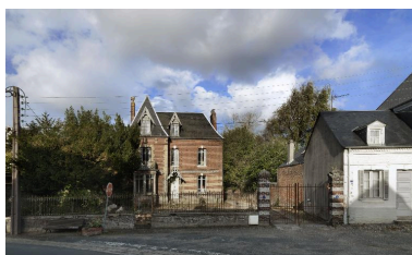
Vue générale depuis la Grande Rue. Phot. Thierry Lefébure IVR22_20148000643NUC2A
