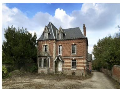
Ancienne maison du directeur de la fonderie, vue depuis la cour. Phot. Thierry Lefébure IVR22_20148000644NUC2A
