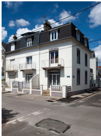
Vue générale. Phot. Pierre Thibaut IVR31_20146202201NUCA
