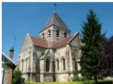
Vue générale, depuis le sud-est. Phot. Frédéric Fournis IVR22_20040202631NUC2A
