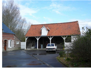
Vue de la charretterie. Phot. Inès Guérin IVR22_20078005621NUCA
