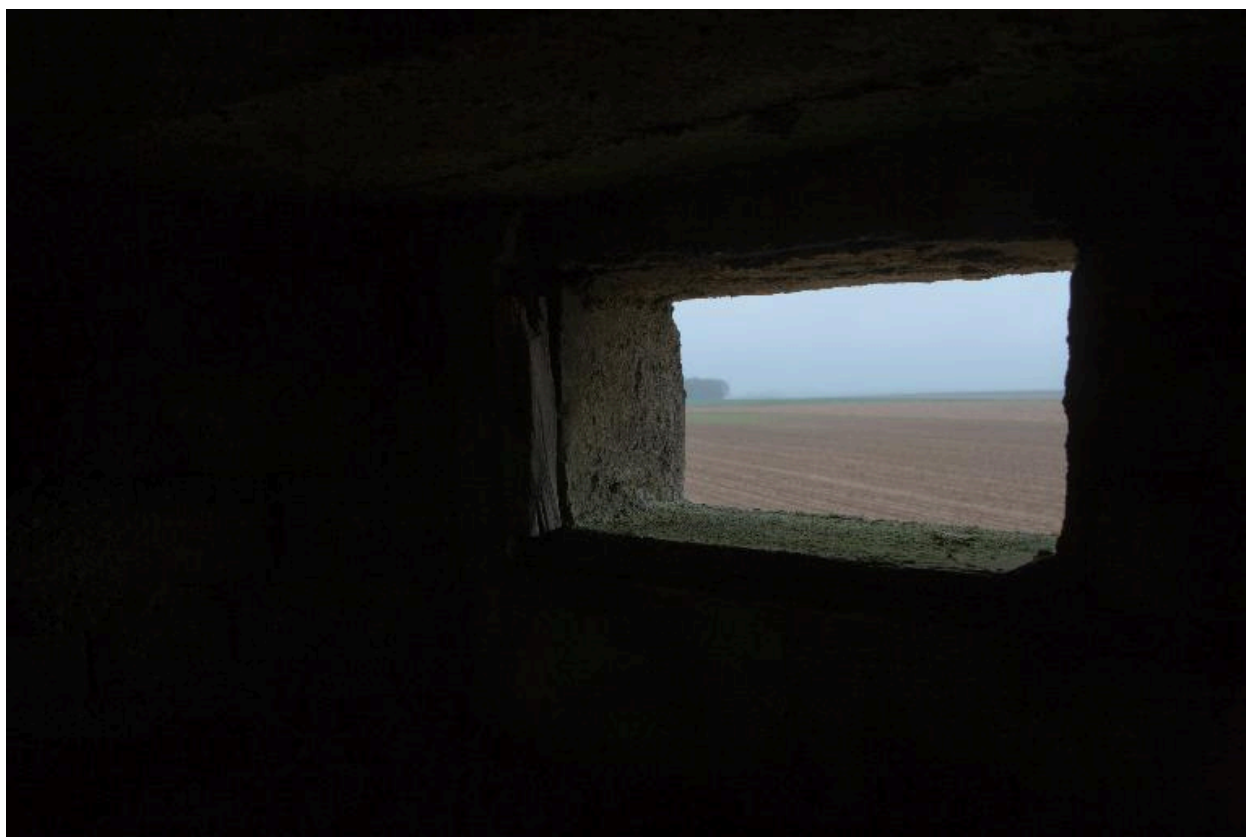
Vue de détail d'une ouverture.
