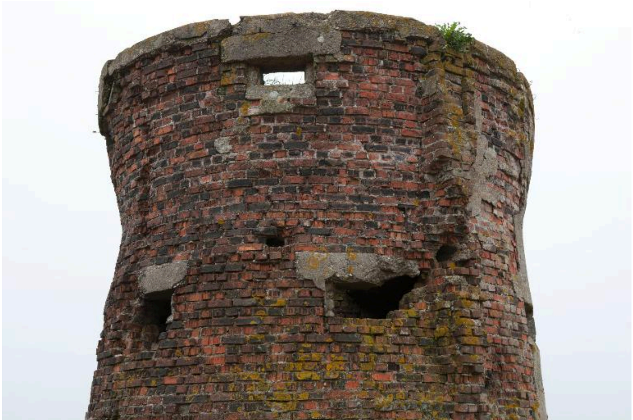
Vue de détail des parties hautes du poste d'observation.
