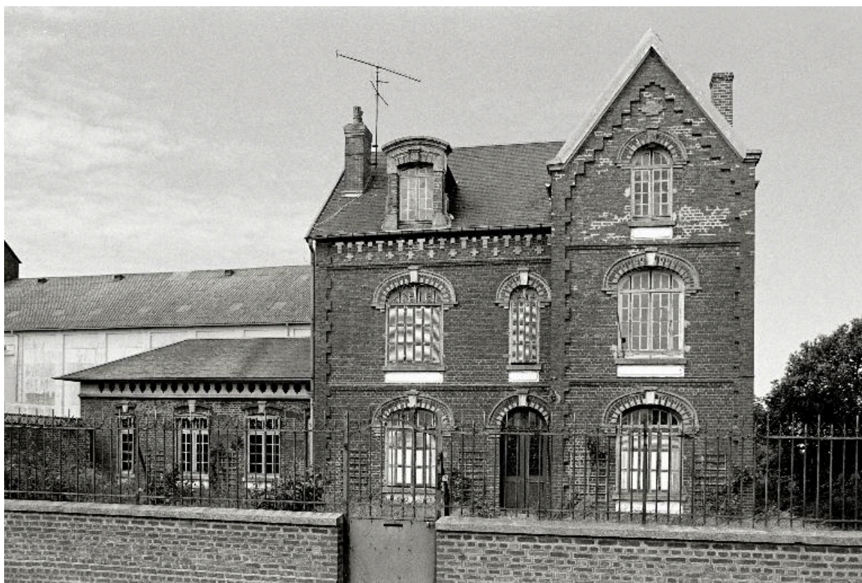
Vue générale depuis la rue en 1990
