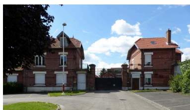
L'ancienne conciergerie et le logement du directeur.
