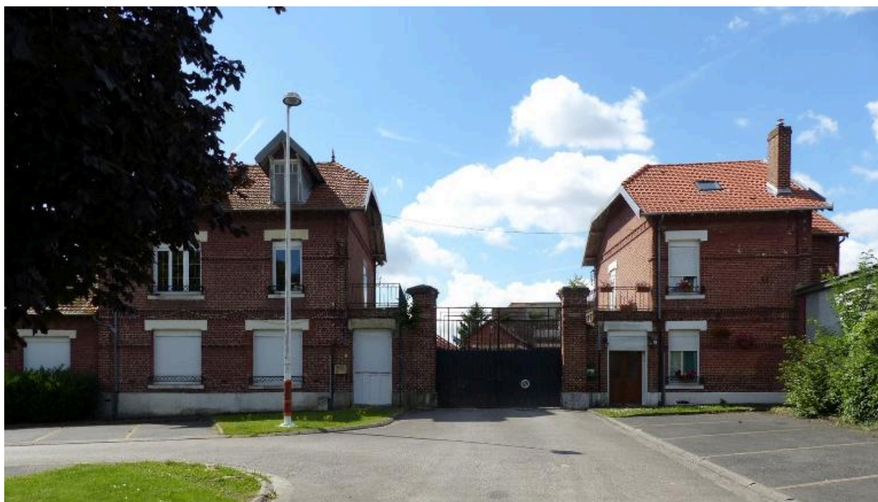
L'ancienne conciergerie et le logement du directeur.
