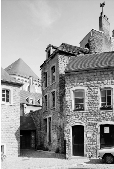
Façade sur voie avant restauration. Phot. Éric Dessert, Phot. Jean-Michel Périn IVR31_19806202458X
