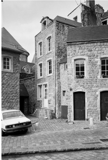
Angle sud-ouest après restauration. Phot. Philippe Caudroit IVR31_19846200160X
