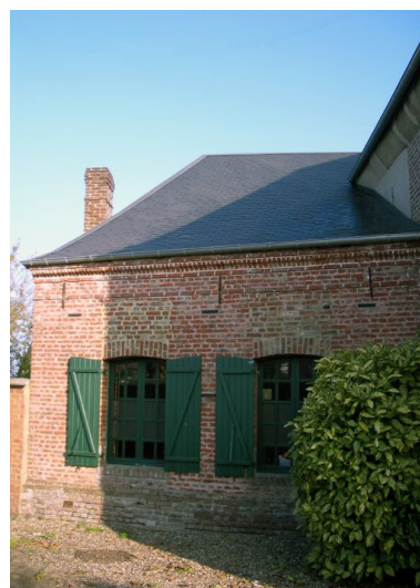
Vue de l'annexe flanquant le mur pignon nord. Phot. Inès Guérin IVR22_20058005181NUCA
