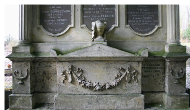
Base de la stèle architecturée : détail du décor sculpté. Phot. Caroline Vincent IVR22_20078000659NUCA
