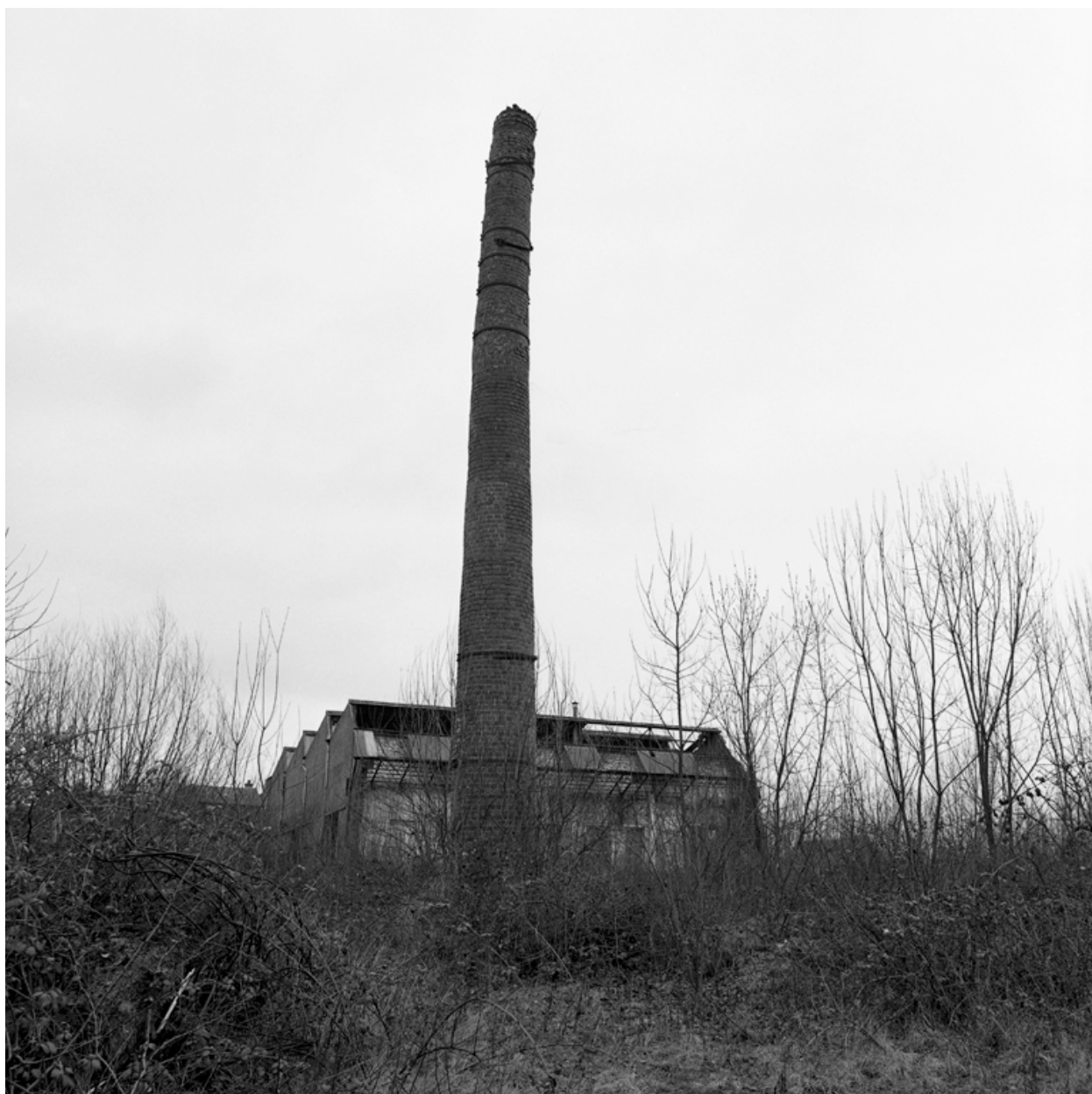
Vue nord de la cheminée et des anciens ateliers de fabrication.
