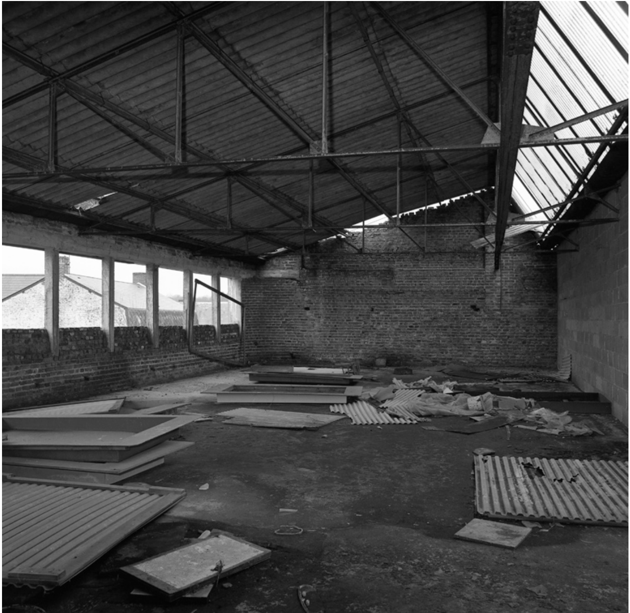
Vue intérieure des anciens ateliers de fabrication.
