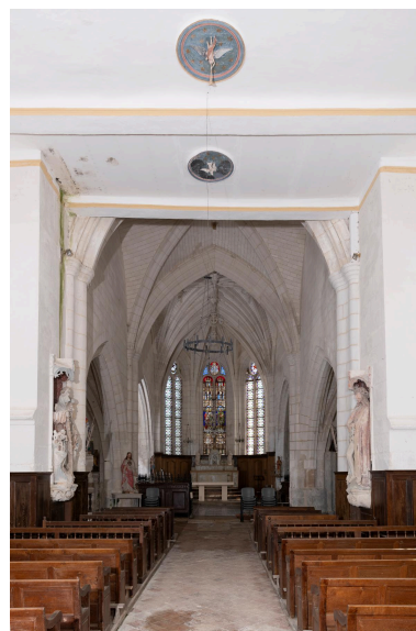
Vue générale vers le chœur. Phot. Marc Kérignard IVR32_20236000783NUCA
