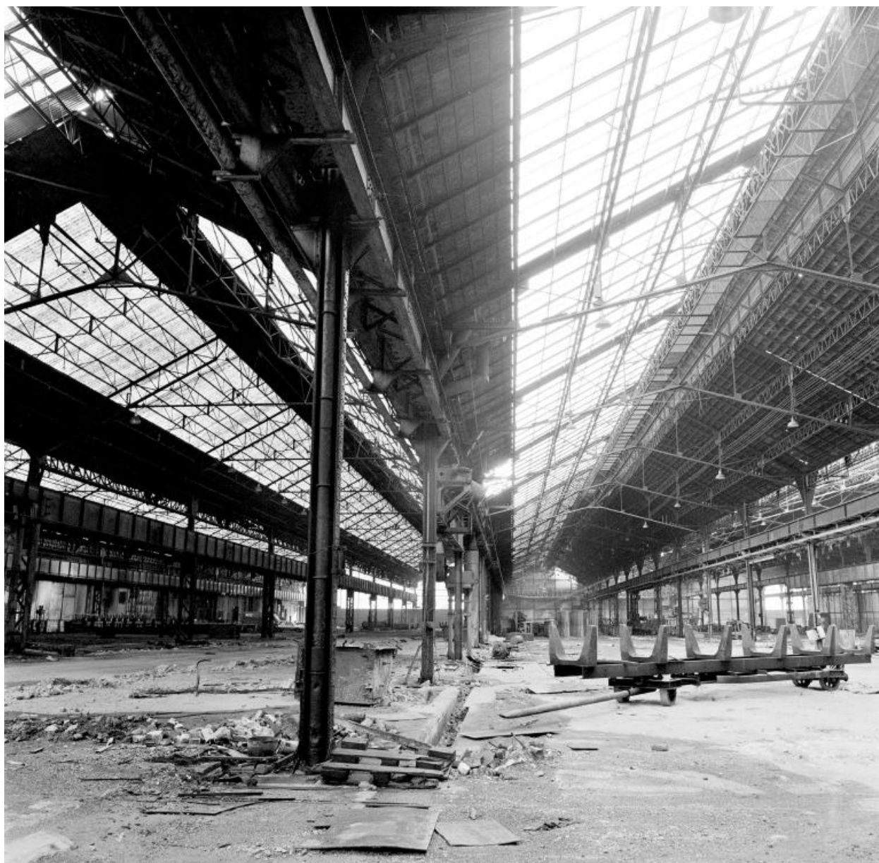
Vue intérieure des ateliers (usine B) .
