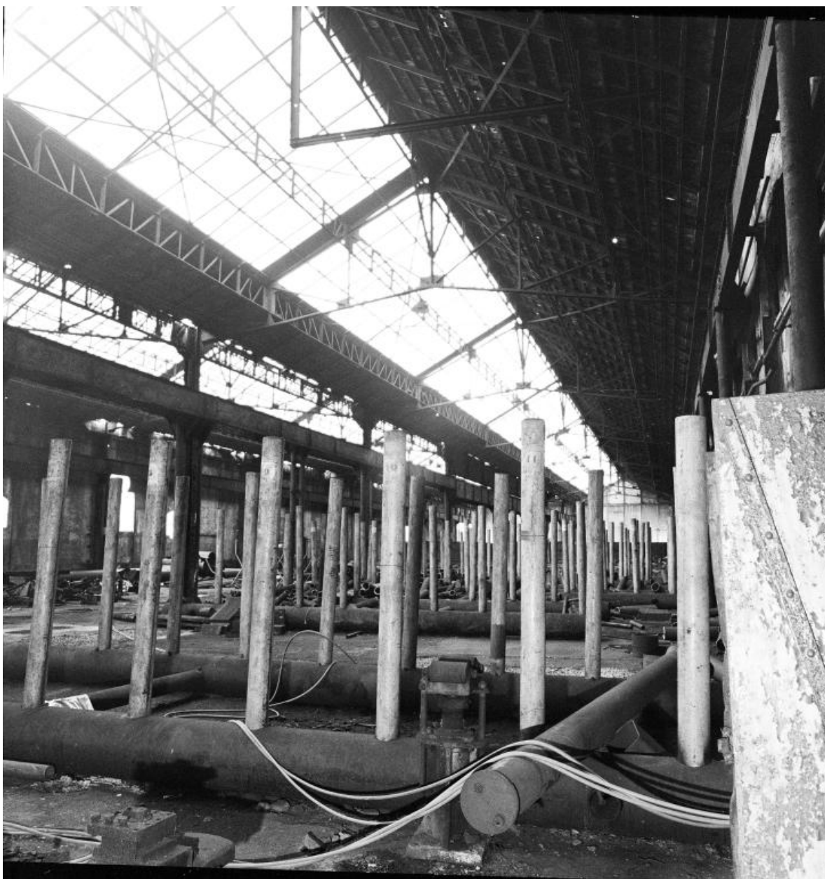
Aire de stockage des tubes (usine B).
