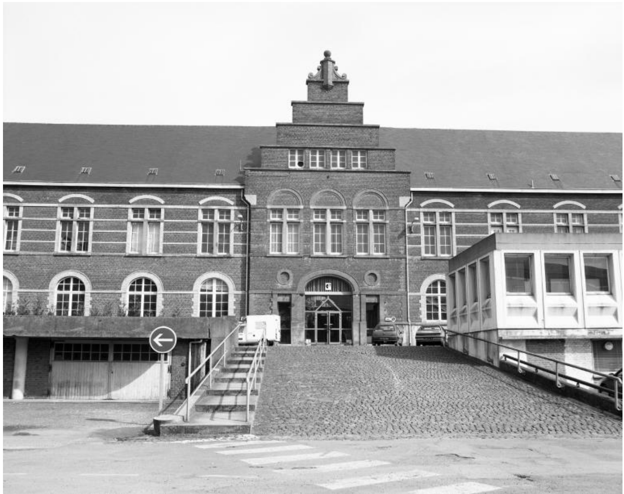
Élévation postérieure des grands bureaux. L'entrée (façade-pignon).
