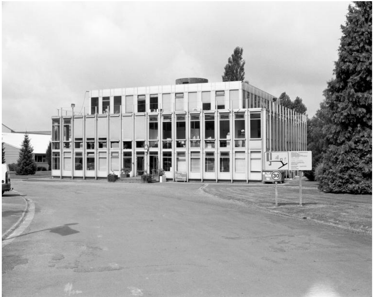
Vue générale du centre de recherche.
