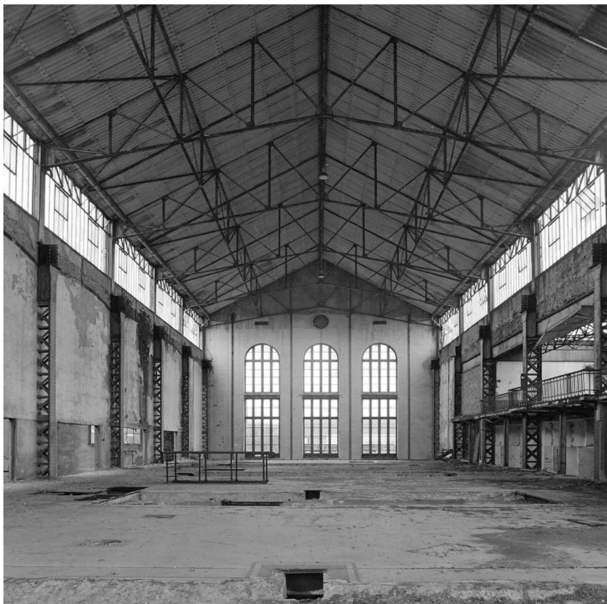
La centrale électrique en 1990 (usine B).
