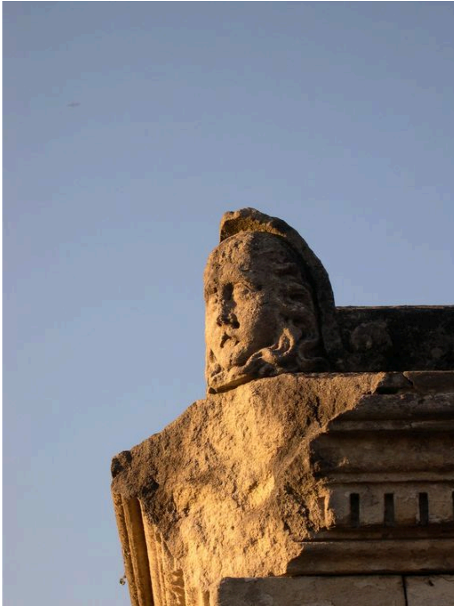
Vue de détail sur les acrotères.
