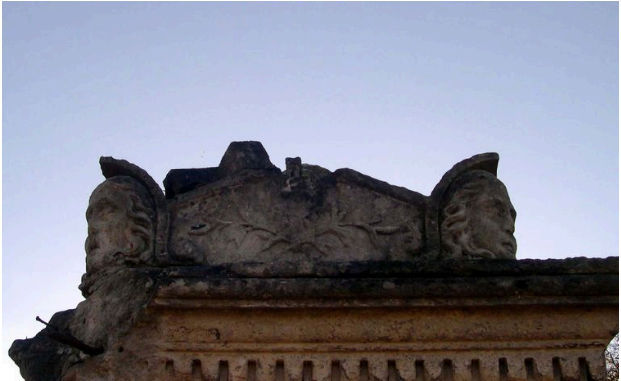
Vue de détail du couronnement, face est.
