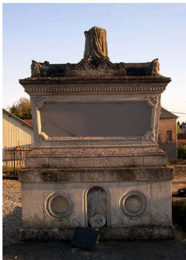
Vue générale depuis le nord. Phot. Isabelle Barbedor IVR22_20078010612NUCA
