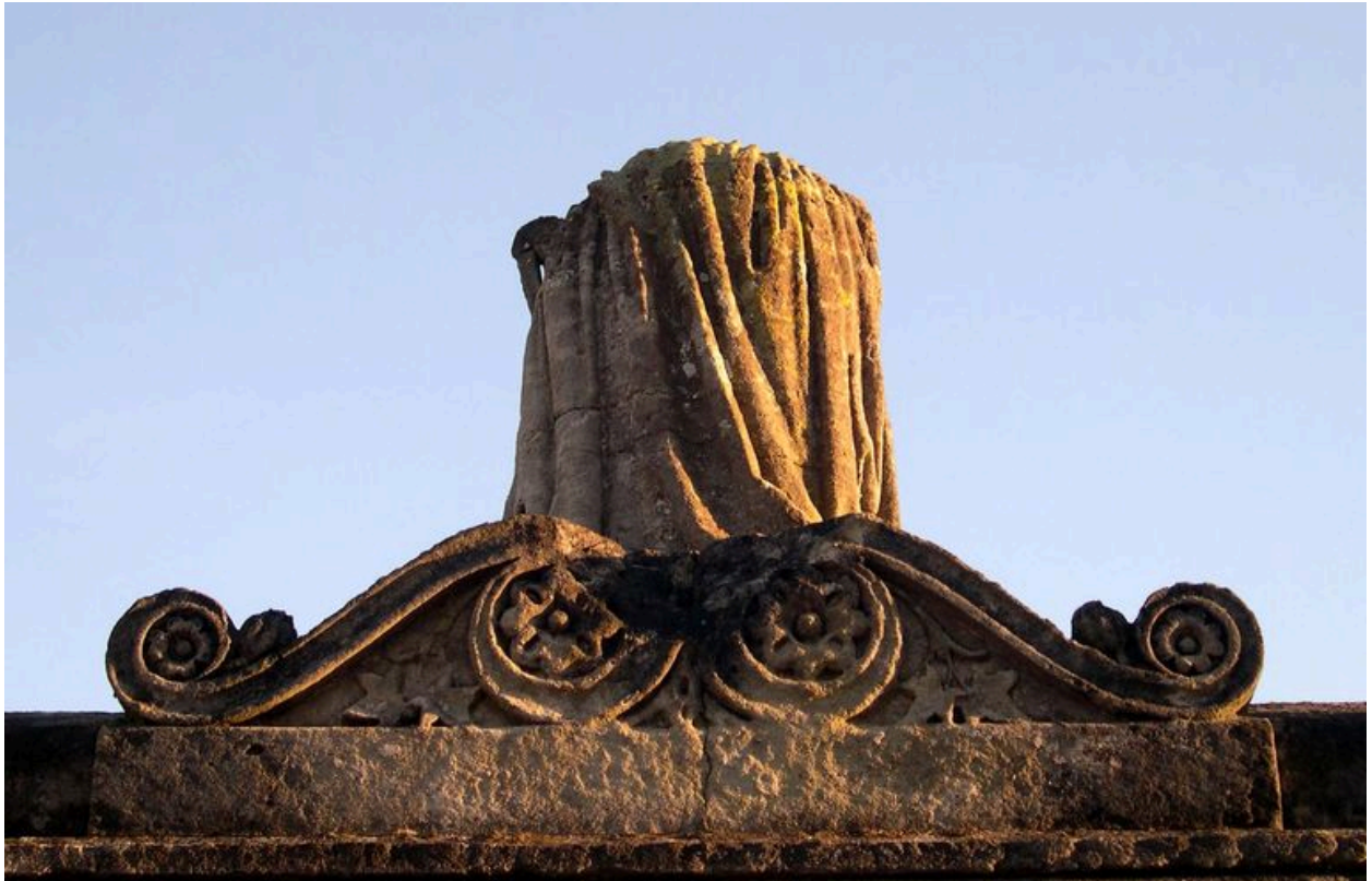
Vue de détail du couronnement, face nord.
