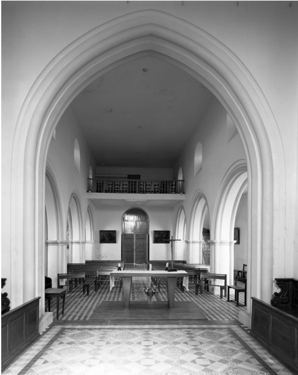
Vue intérieure de la nef, du chœur vers l'entrée.
