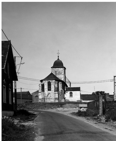
Vue du chevet. Phot. Thierry Lefébure IVR22_19910201402V
