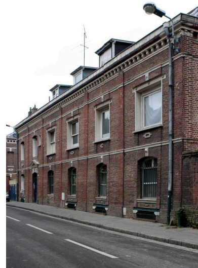
Bureaux. Phot. Thierry Lefébure IVR22_20038001096NUCA
