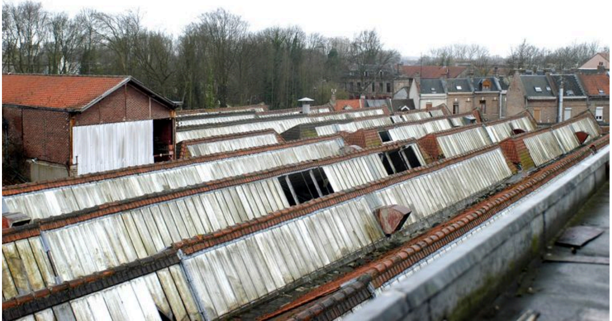
Vue des toitures.
