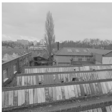
Vue des toitures. Phot. Thierry Lefébure IVR22_20038000013X
