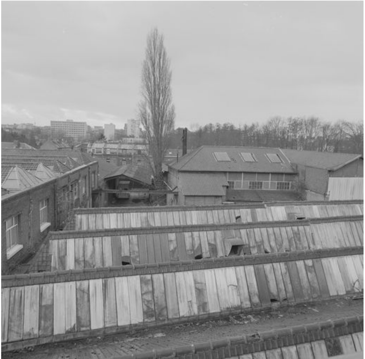
Vue des toitures.
