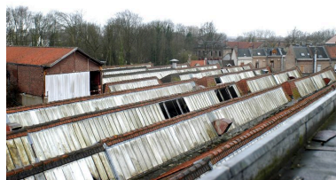
Vue des toitures. Phot. Thierry Lefébure IVR22_20038001099NUCA
