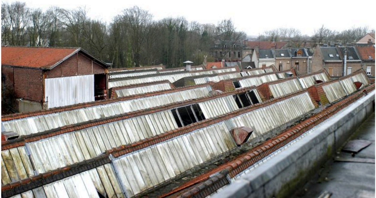
Vue des toitures.
