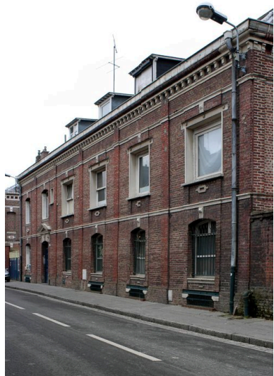
Bureaux. Phot. Thierry Lefébure IVR22_20038001096NUCA
