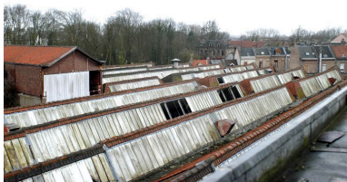
Vue des toitures. Phot. Thierry Lefébure IVR22_20038001099NUCA
