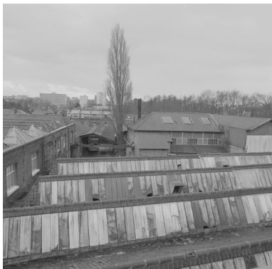
Vue des toitures. Phot. Thierry Lefébure IVR22_20038000013X
