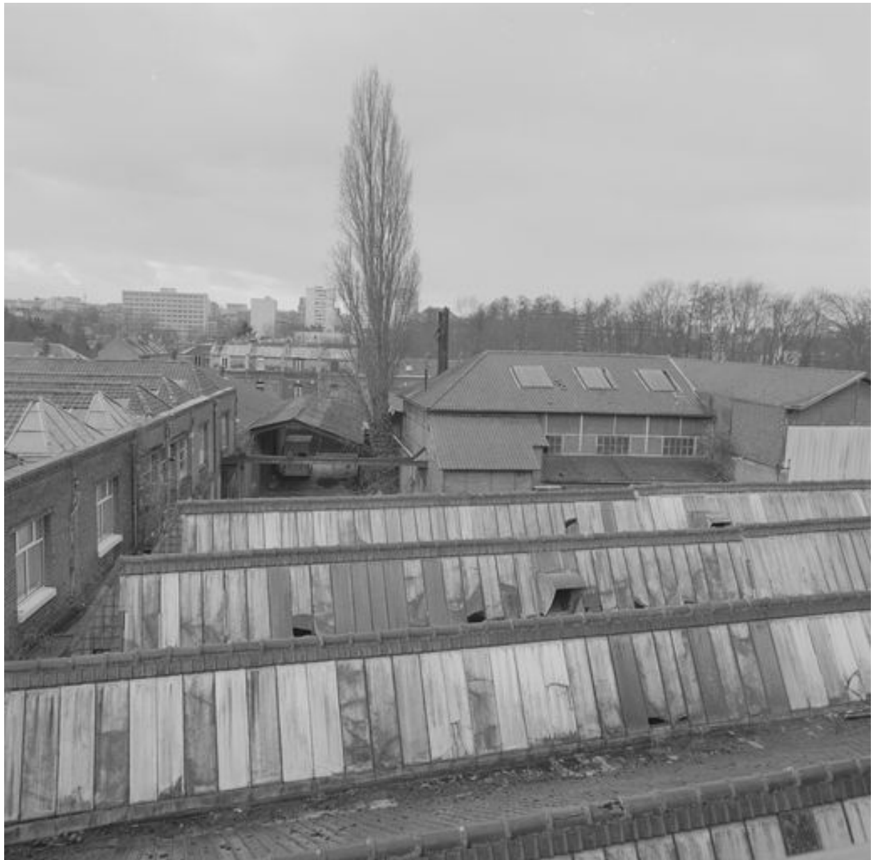
Vue des toitures.
