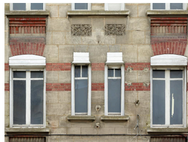
Vue de détail du décor de brique et de feuillages du second niveau de la façade. Phot. Delphine Volto-Jourdan IVR32_20216200586NUCA
