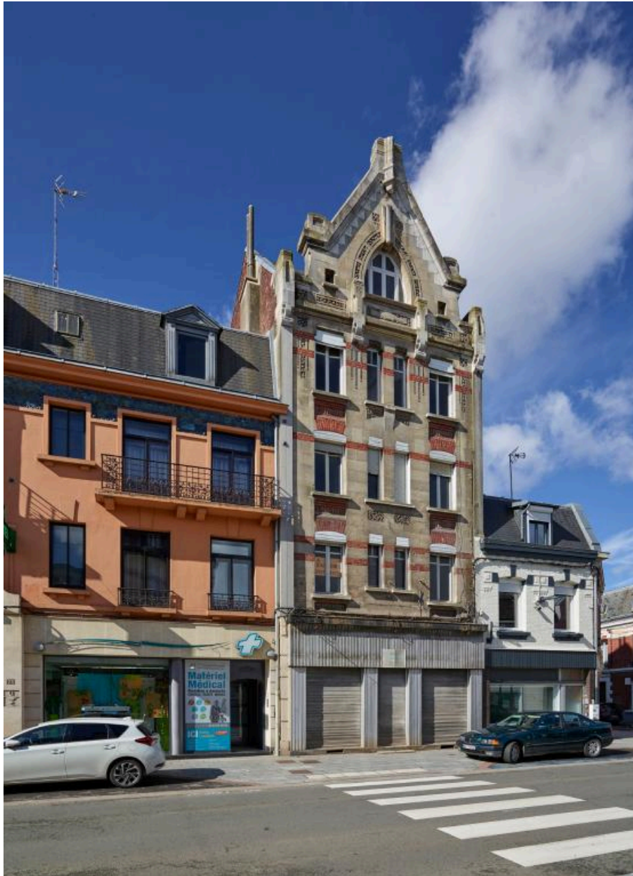
Vue générale de la façade principale depuis la rue de Péronne.
