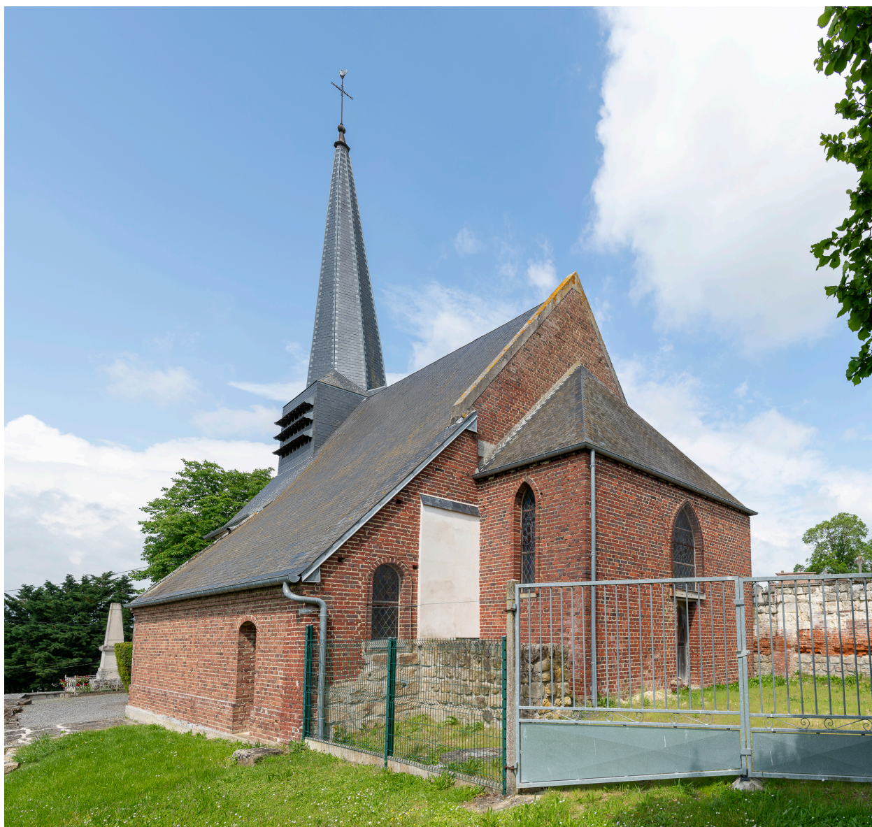
Vue depuis le sud-est.
