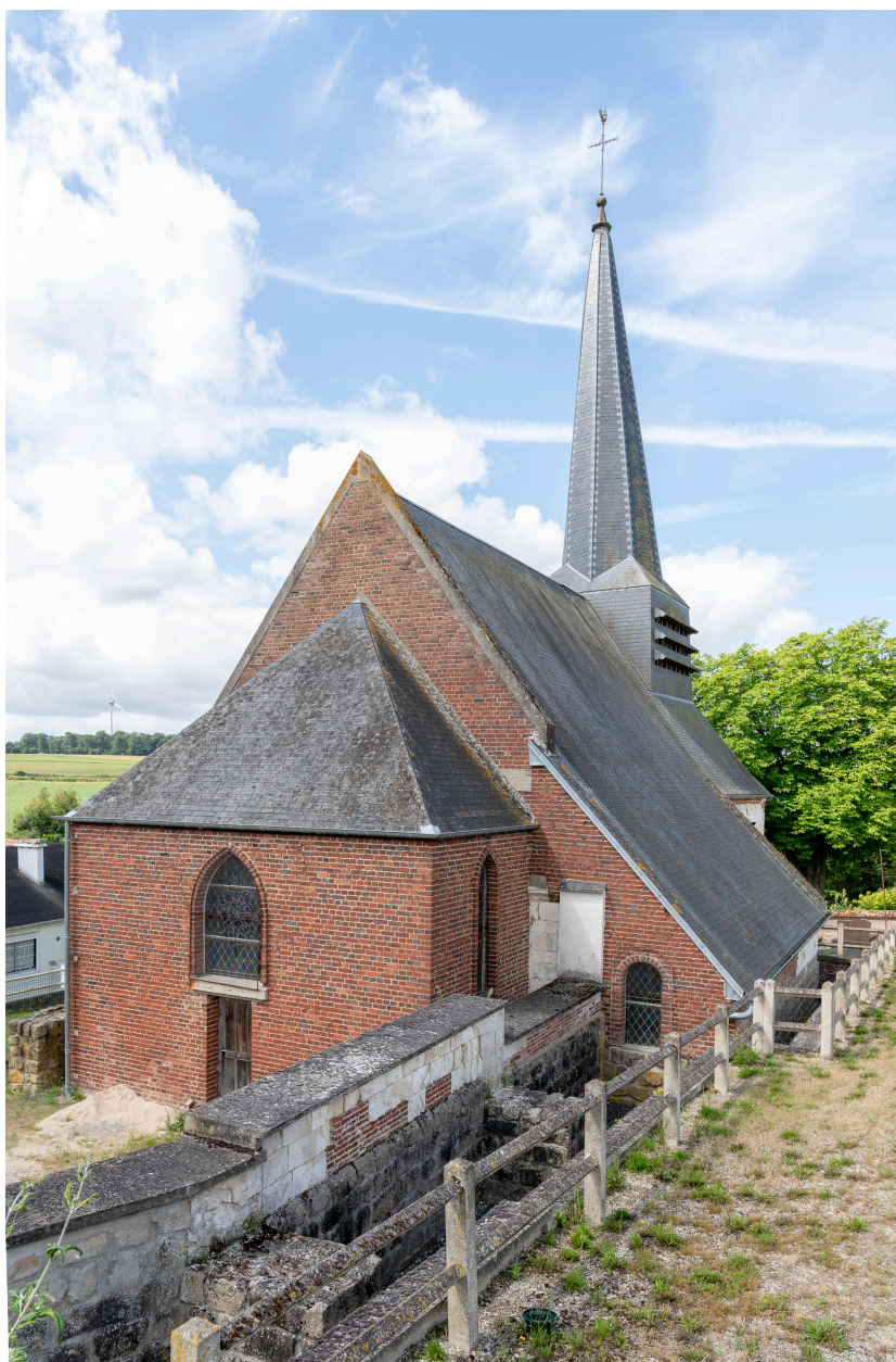
Vue du chœur depuis le cimetière en surplomb.
