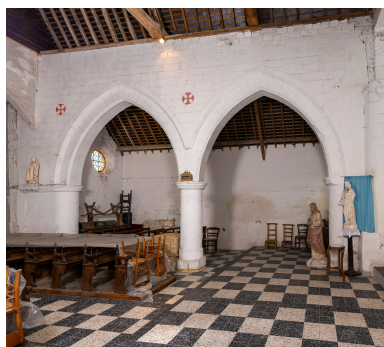
Vue intérieure vers la chapelle nord. Phot. Marc Kérignard IVR32_20246000650NUCA
