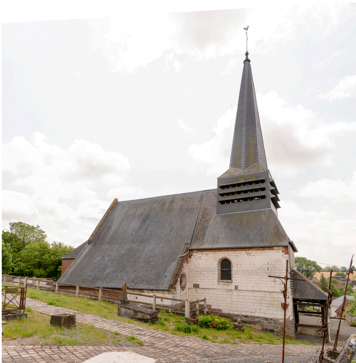
Élévation nord de l'église.
