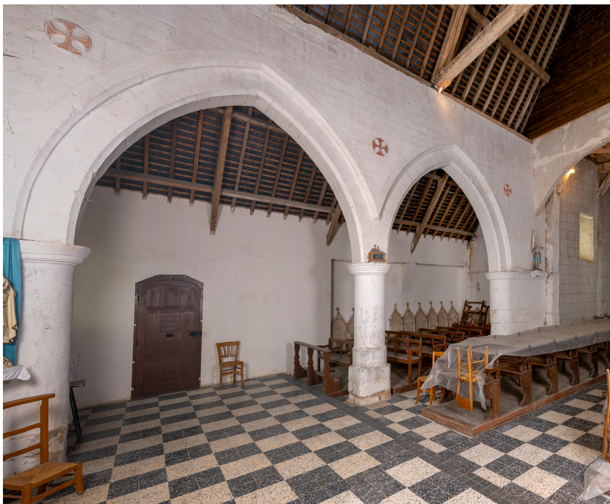
Vue intérieure vers la chapelle sud.
