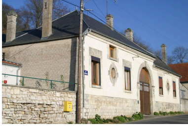
Vue générale. Phot. Inès Guérin IVR22_20030202000NUCA
