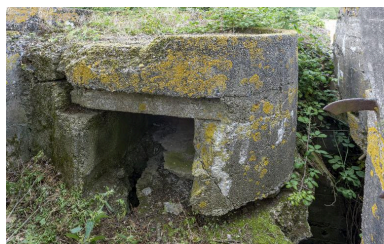
Resserre à mitrailleuse sous la plateforme nord-est Phot. Jean-Marc Ramette IVR31_20145904795NUCA
