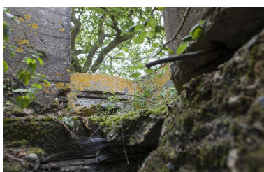
Conduit d'accès aux positions de mitrailleuse Phot. Jean-Marc Ramette IVR31_20145904798NUCA
