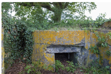
Resserre à mitrailleuse sous la plateforme sud-ouest Phot. Jean-Marc Ramette IVR31_20145904796NUCA
