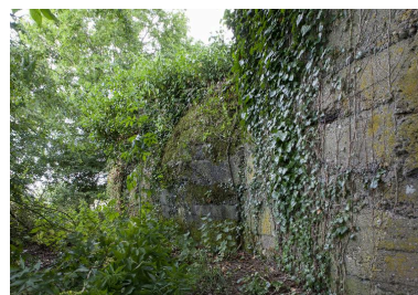
Elévation sud-ouest Phot. Jean-Marc Ramette IVR31_20145904799NUCA
