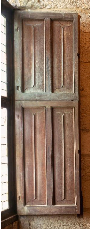
Vue du revers des vantaux de la fenêtre. Phot. Laurent Jumel IVR22_19966001791XA
