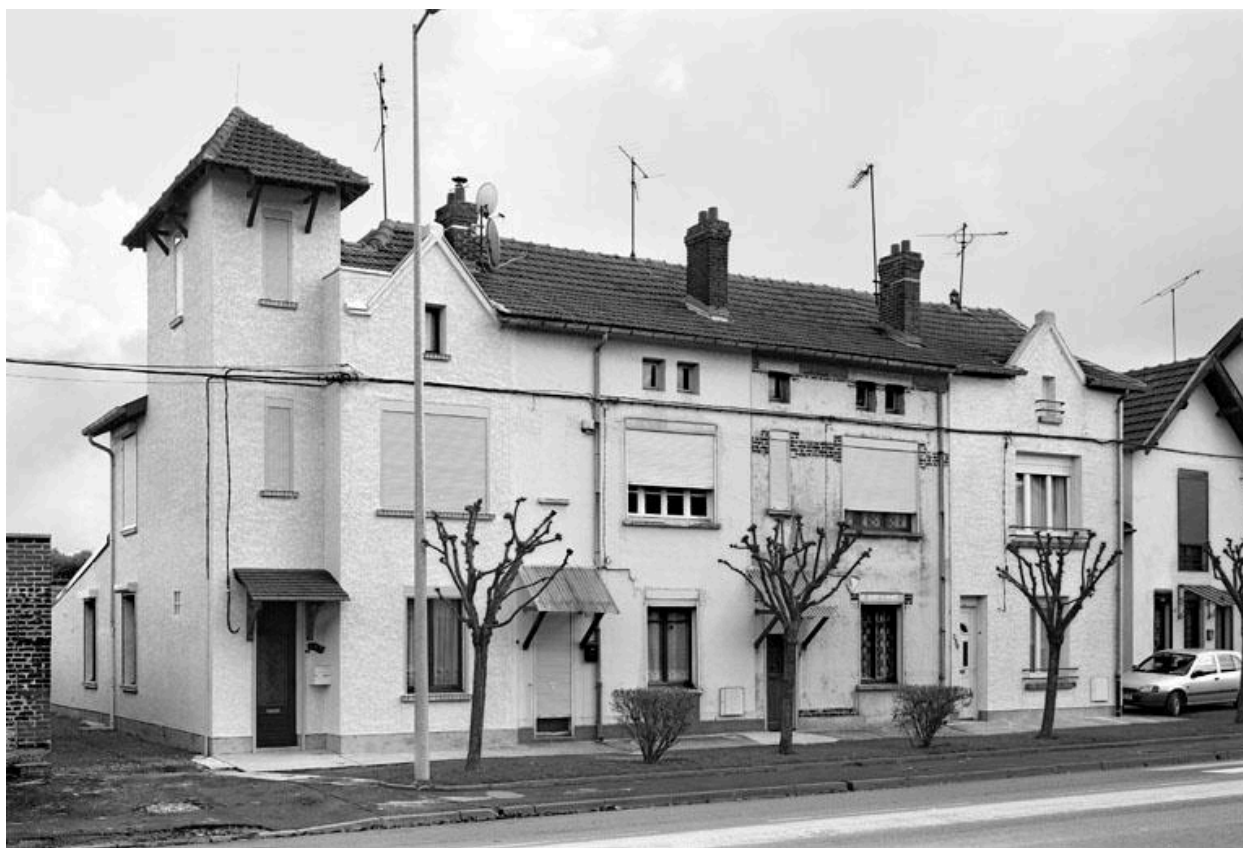
Vue des 4 maisons, formant les N°236, 240, 246 et 250.
