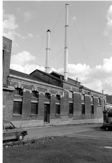
Chaufferie, élévation antérieure. Phot. Benoît Dufournier IVR22_19888001084Z
