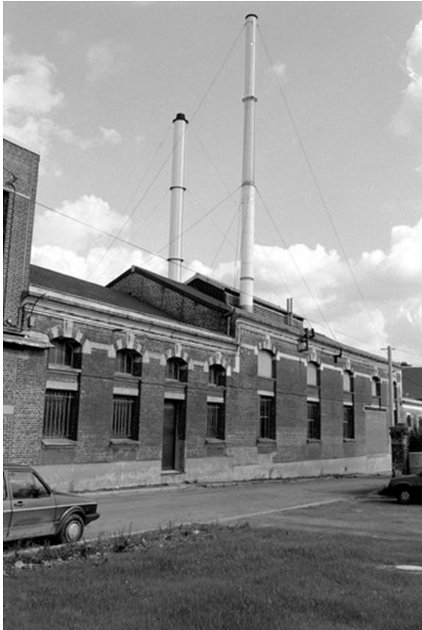
Chaufferie, élévation antérieure.
