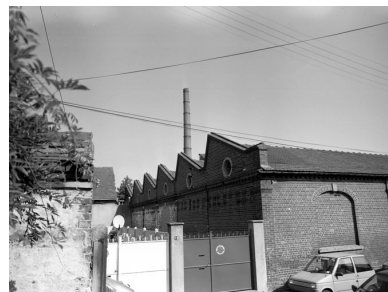
Pignons sud de l'atelier de fabrication avec sheds.
