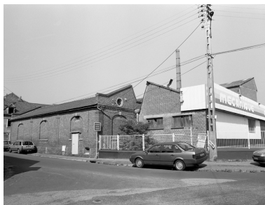
Mur ouest de l'atelier de fabrication.
