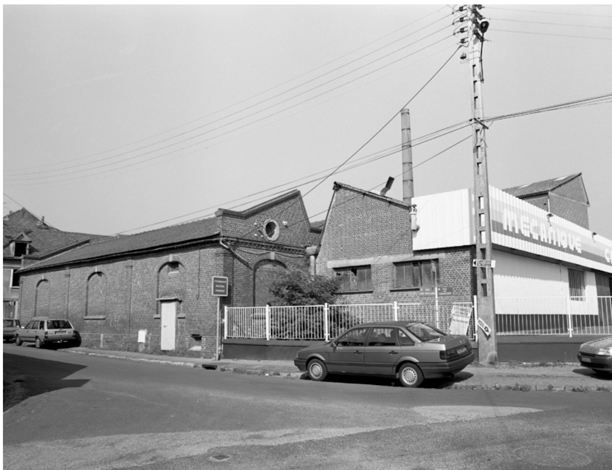
Mur ouest de l'atelier de fabrication.
