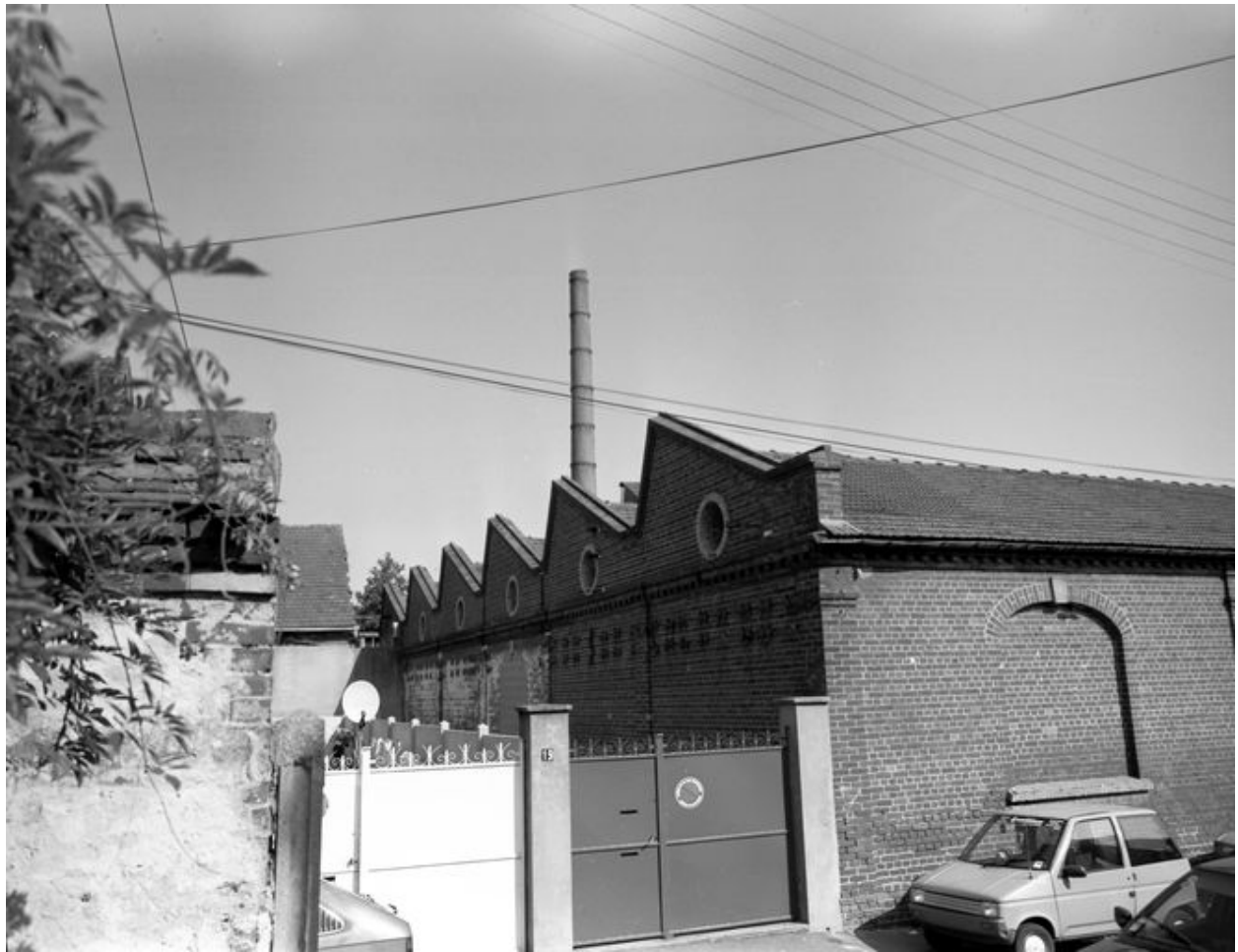
Pignons sud de l'atelier de fabrication avec sheds.
