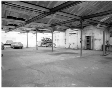
Intérieur de l'atelier de fabrication avec piliers en fonte. Phot. Laurent Jumel IVR22_19966002650X
