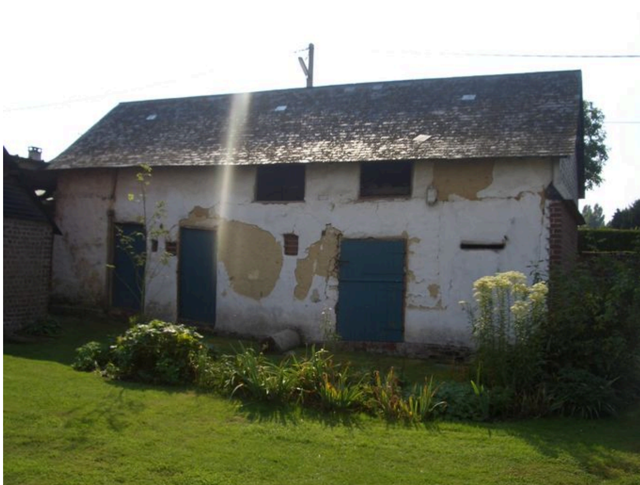
Vue des écuries longeant la rue.
