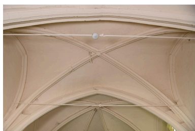
Voûte de la première travée du chœur. Phot. Marc Kérignard IVR32_20226001063NUCA
