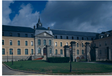
La grille d'entrée. Phot. Thierry Lefébure IVR22_19940200814XA
