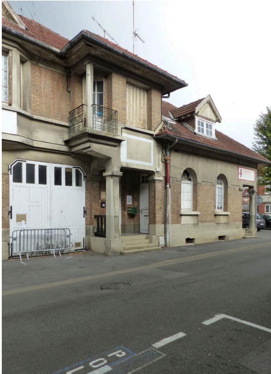
Vue du porche d'entrée d'un logement et de l'ancienne remise de matériel d'incendie.
