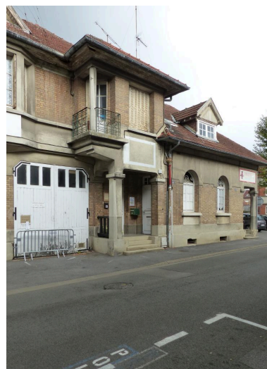
Vue du porche d'entrée d'un logement et de l'ancienne remise de matériel d'incendie. Phot. Isabelle Barbedor IVR32_20210205140NUCA
