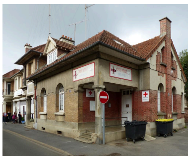
Vue de l'ancien dispensaire. Phot. Isabelle Barbedor IVR32_20210205139NUCA
