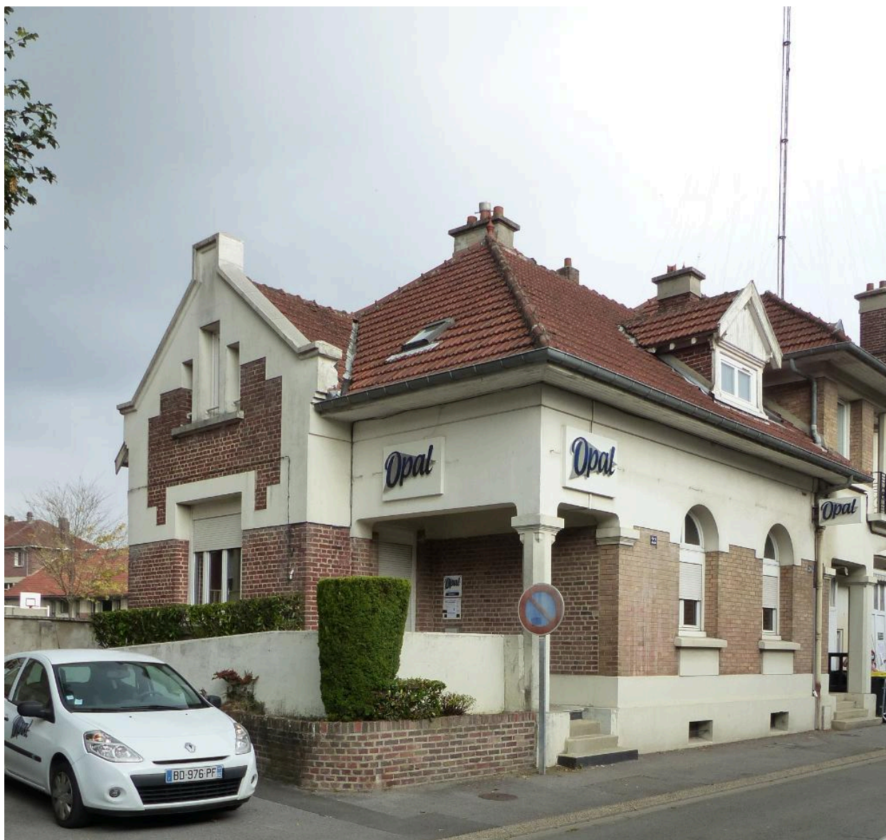
Vue de l'ancien commissariat de police.
