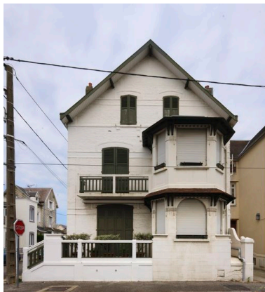
Mur-pignon (détail). Phot. Hubert Bouvet IVR31_20136200246NUCA
