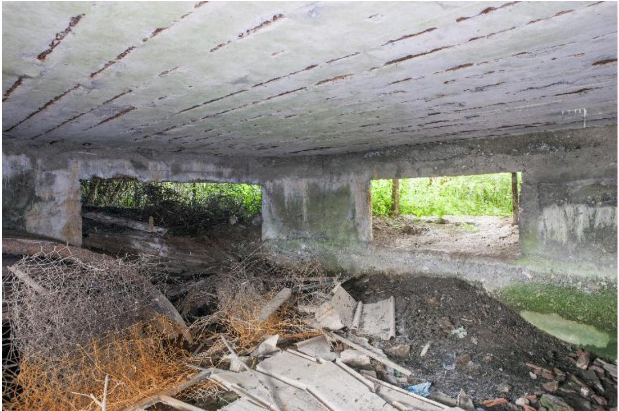
Vue intérieure de la chambre de tir, vers le nord : les deux embrasures de tir.
