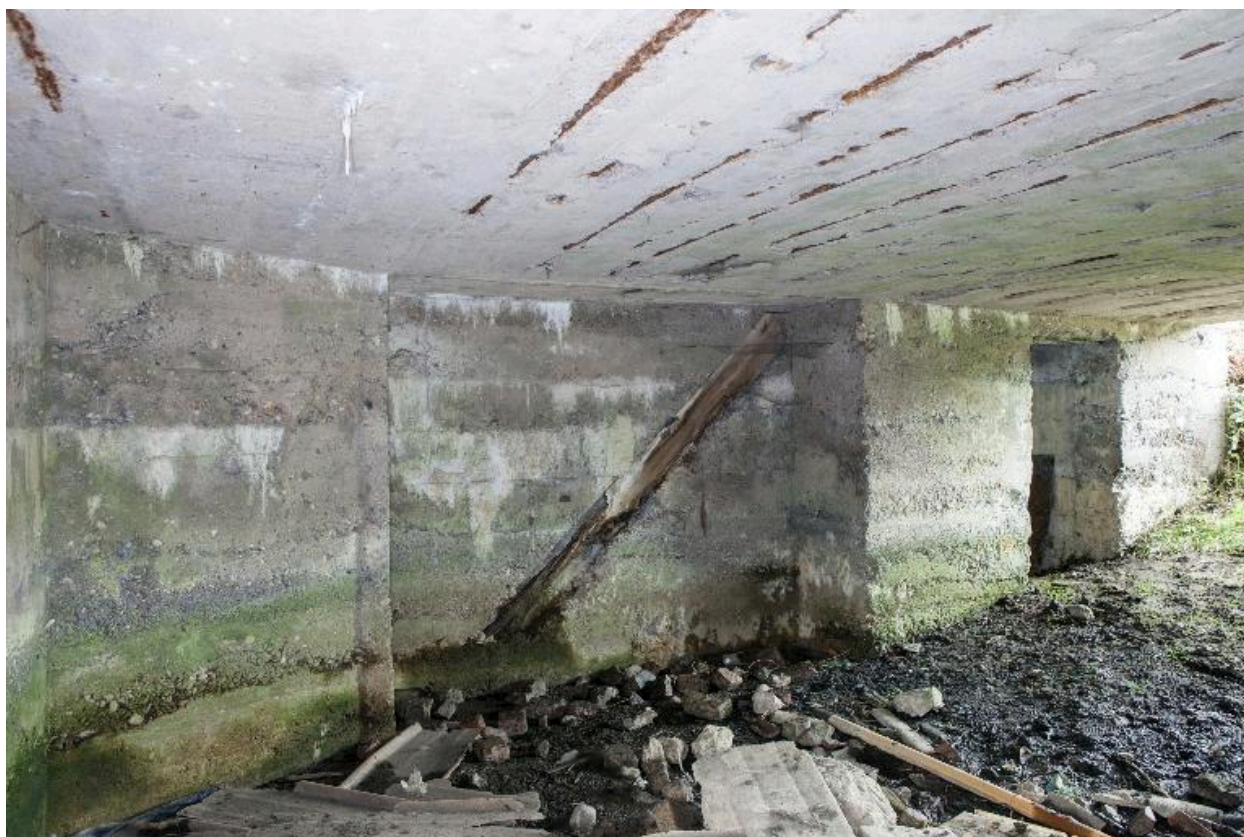
Vue intérieure de la chambre de tir vers le sud. A droite l'accès au poste d'observation
