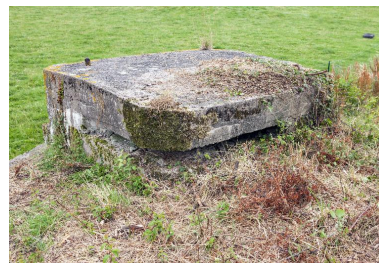
Depuis le couvrement : poste d'observation Phot. Pierre Thibaut IVR32_20165900975NUCA
