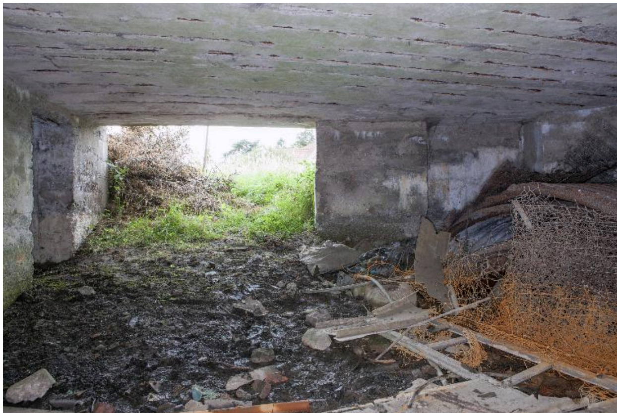
Vue intérieure de la chambre de tir, vers le sud. A gauche de l'embrasure d'entrée, l'accès au poste d'observation.
