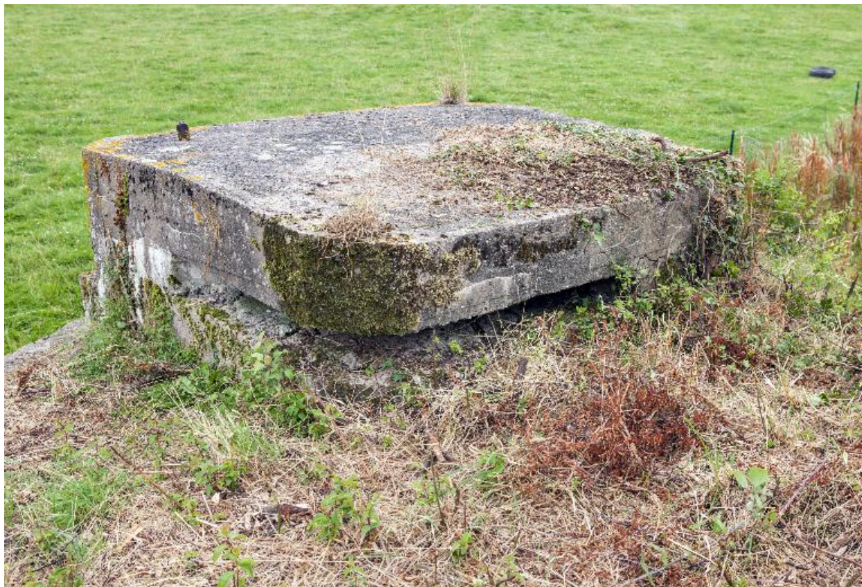
Depuis le couvrement : poste d'observation
