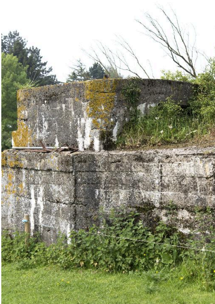
Détail du poste d'observation vers le sud-ouest
