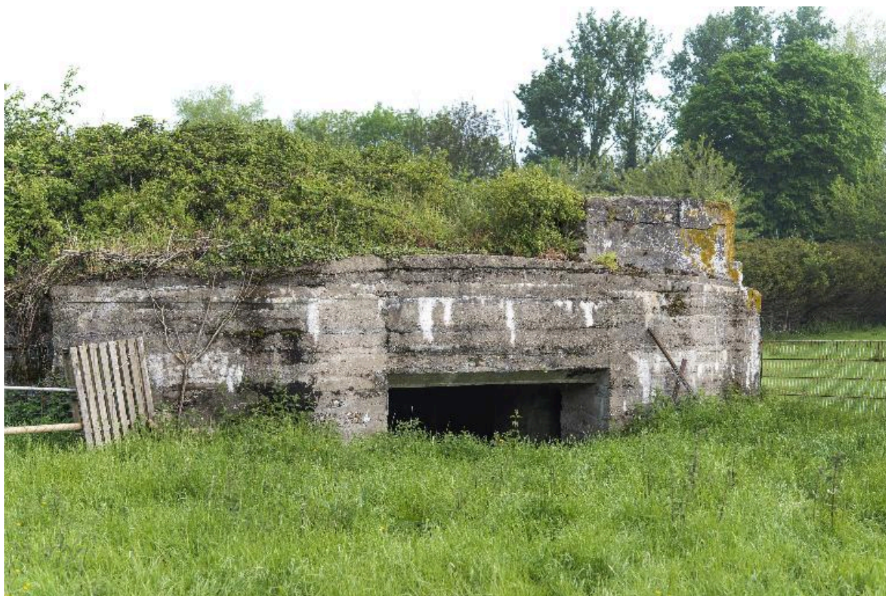
Elévation sud, entrée pour l'artillerie et poste d'observation, à droite sur le couverture
