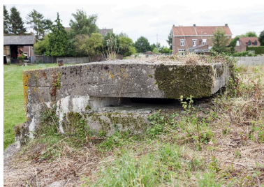
Depuis le couvrement, vers le sud : embrasure du poste d'observation Phot. Pierre Thibaut IVR32_20165900976NUCA
