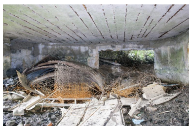
Vue intérieure de la chambre de tir vers l'embrasure de tir ouest Phot. Pierre Thibaut IVR32_20165900970NUCA
