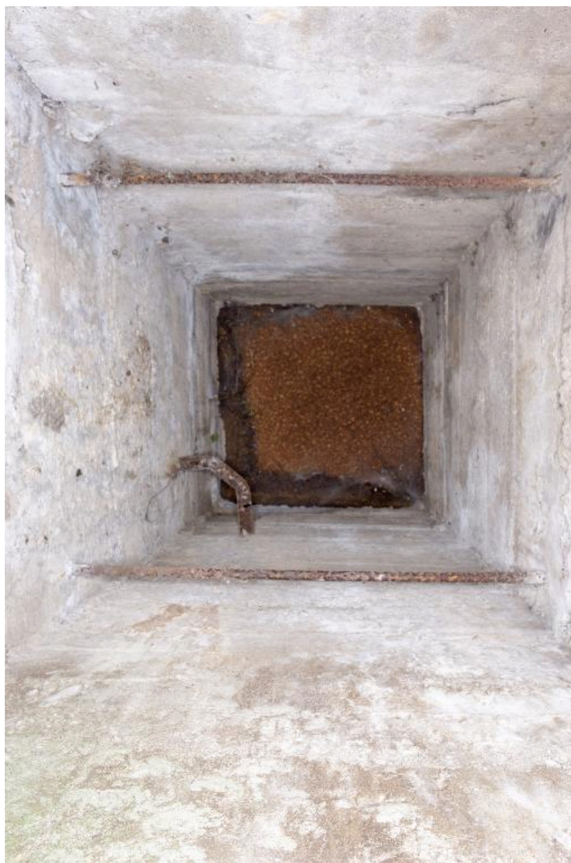
Vue zénithale du poste d'observation
