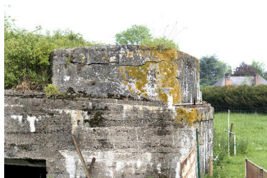
Vers le nord, détail du poste d'observation Phot. Jean-Marc Ramette IVR32_20165901404NUCA
