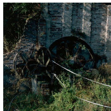
Les vestiges des engrenages de transmission.
