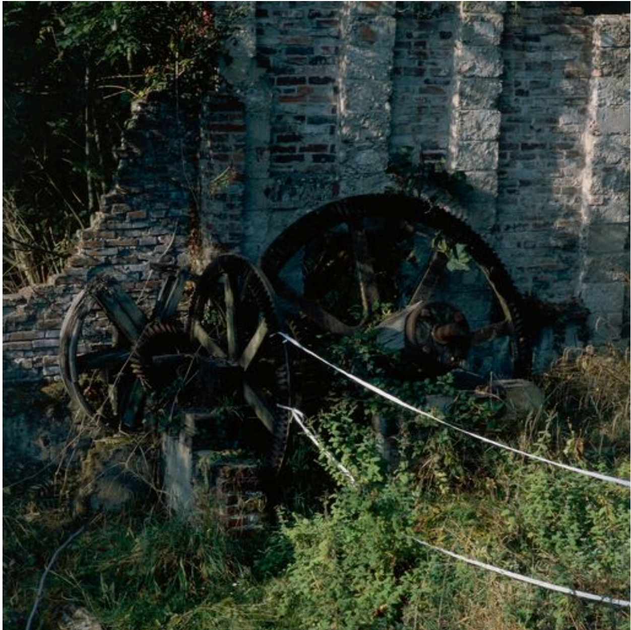
Les vestiges des engrenages de transmission.
