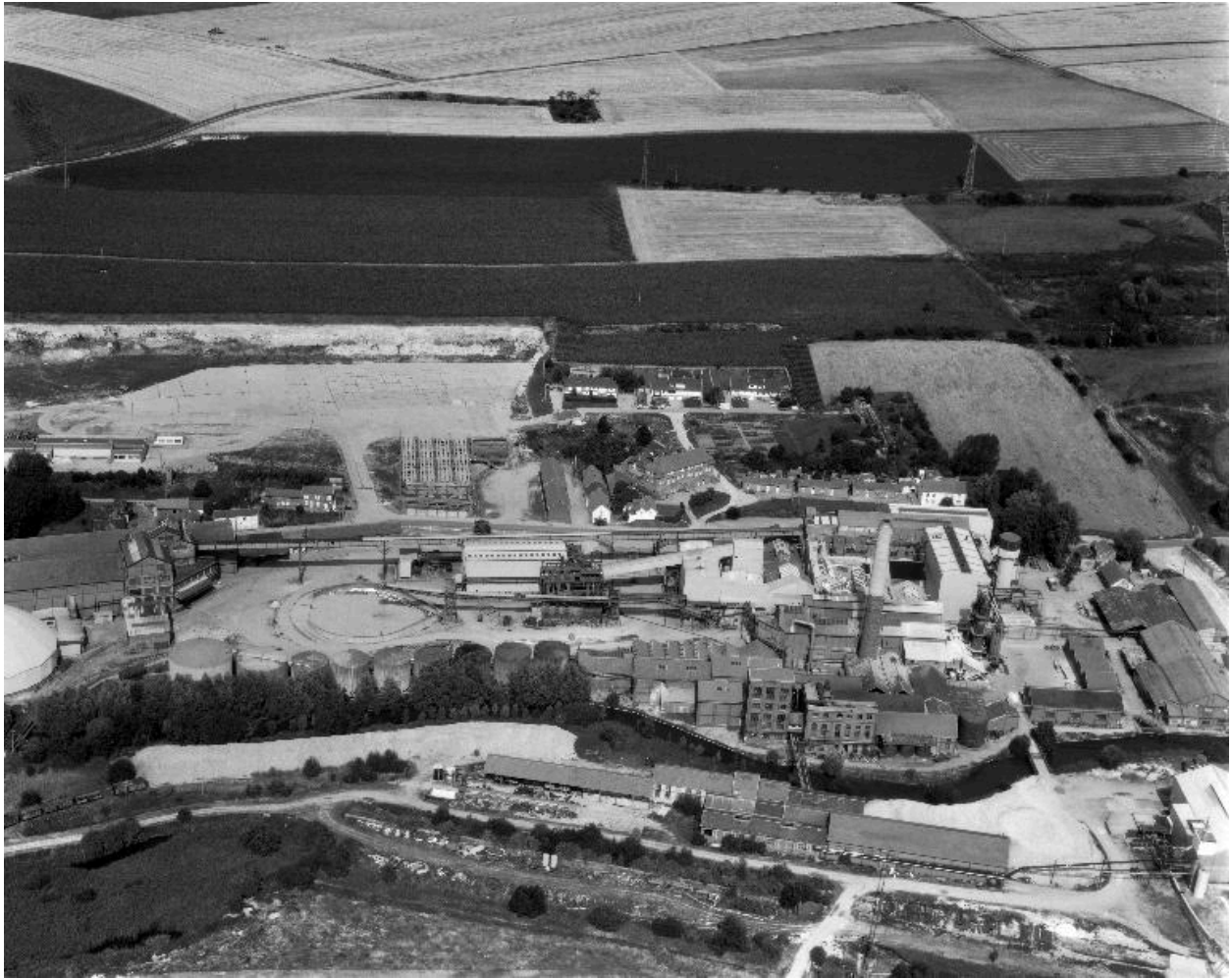
Vue aérienne, flanc sud-ouest.
