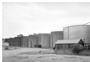
Réservoirs industriels. Phot. Thierry Lefébure IVR22_19888000860X
