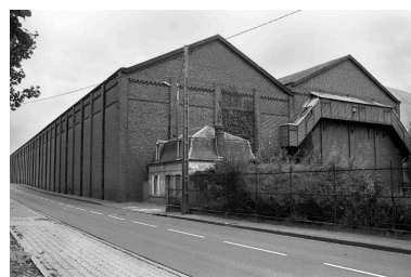
Magasins industriels. Phot. Thierry Lefébure IVR22_19908000823V
