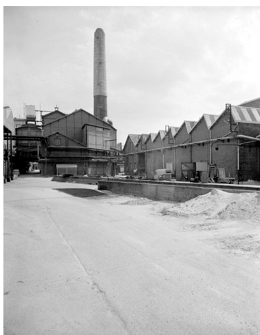
Vue partielle (flanc nord) de la cheminée d'usine, chaufferie. Phot. Thierry Lefébure IVR22_19888000874V
