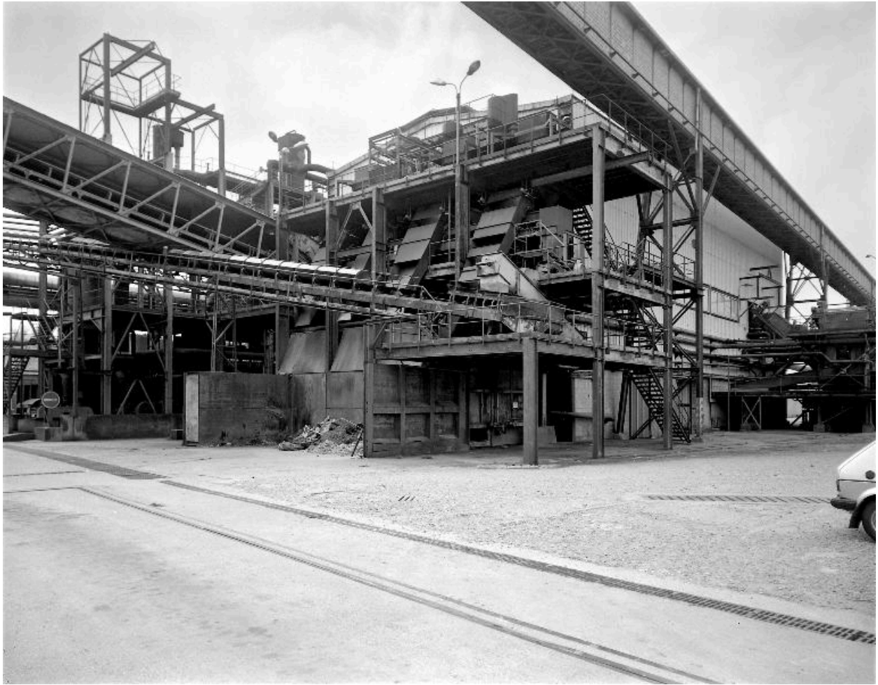
Unité de lavage.
