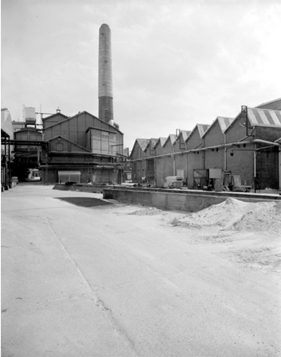
Vue partielle (flanc nord) de la cheminée d'usine, chaufferie.
