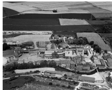
Vue aérienne, flanc sud-ouest. Phot. Phot'R IVR22_19888001401P
