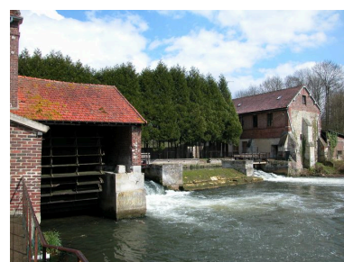
Vue d'ensemble du moulin d'Achon et de la cage de la roue du second moulin. Phot. Bertrand Fournier IVR22_20046002866NUCA
