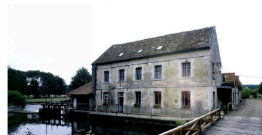
Vue du moulin et de sa cage. Phot. Thierry Lefébure IVR22_20046000357VA
