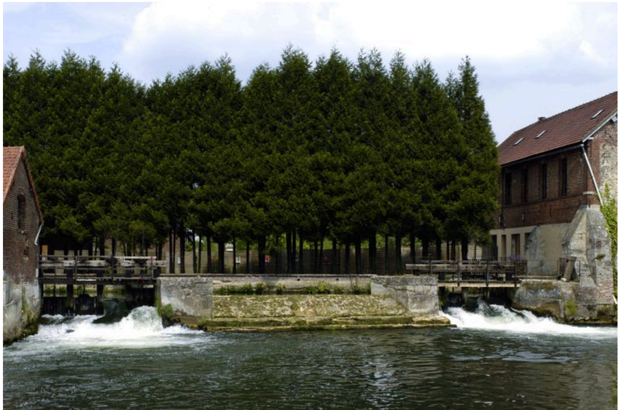
Le déversoir et les vannes de décharge.
