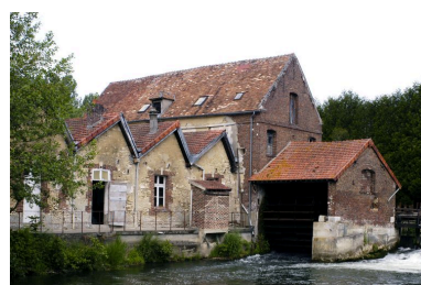
La roue hydraulique et sa cage attenante au pignon du moulin. Phot. Thierry Lefébure IVR22_20046000248NUCA
