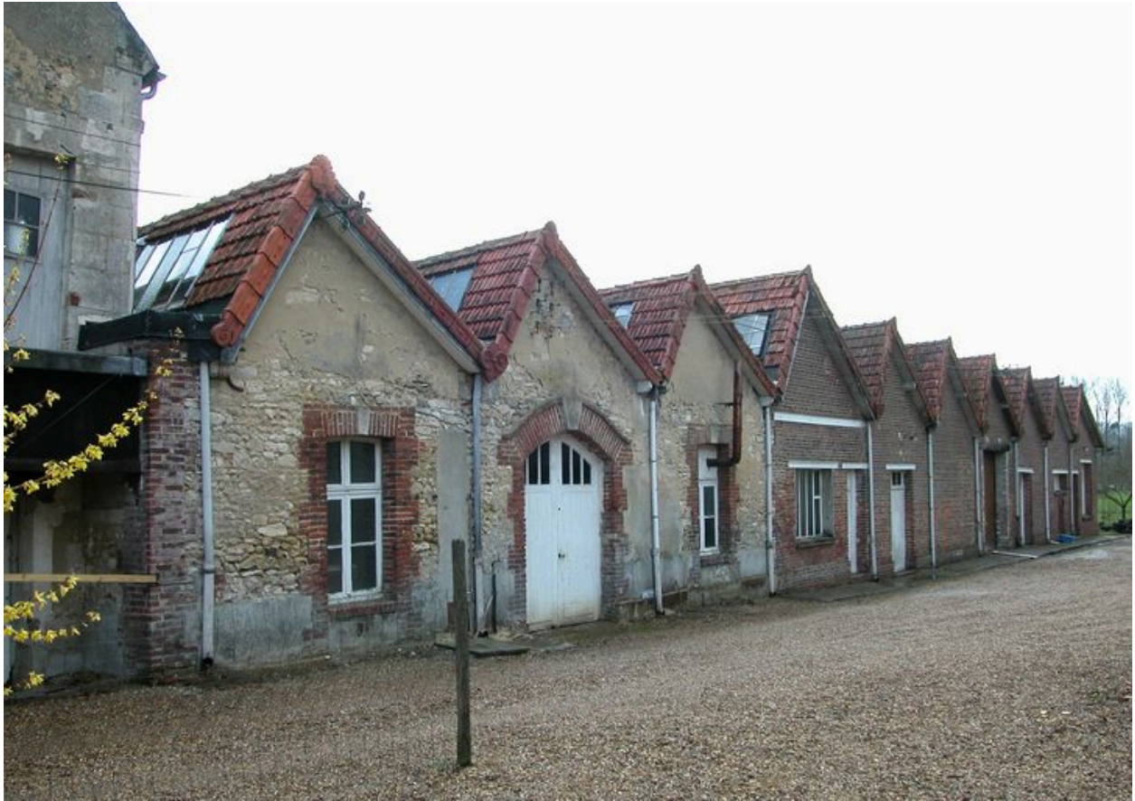
Vue d'ensemble de la façade nord-est des ateliers de broserie.
