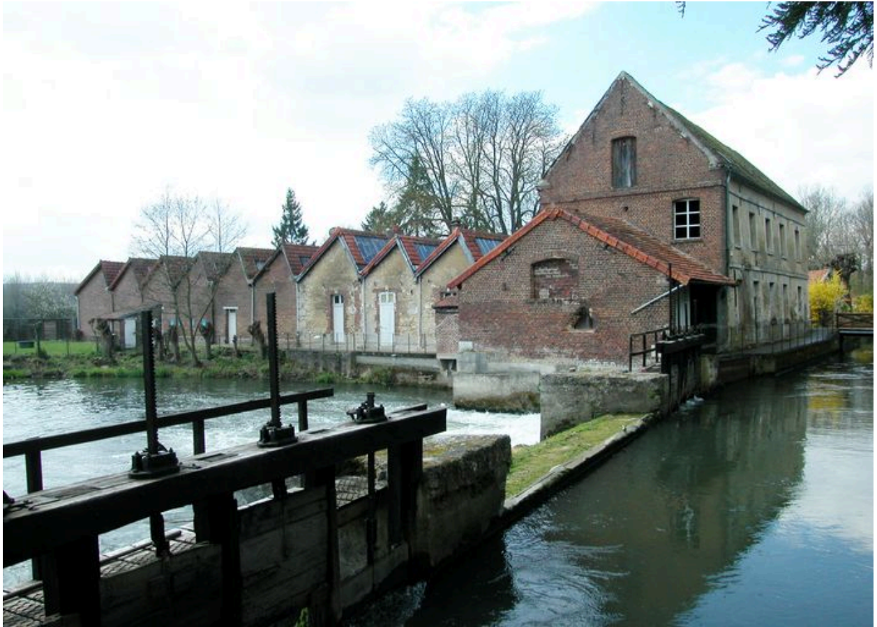
Vue générale de la brosserie et du vannage.
