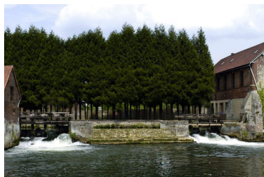
Le déversoir et les vannes de décharge. Phot. Thierry Lefébure IVR22_20046000258NUCA
