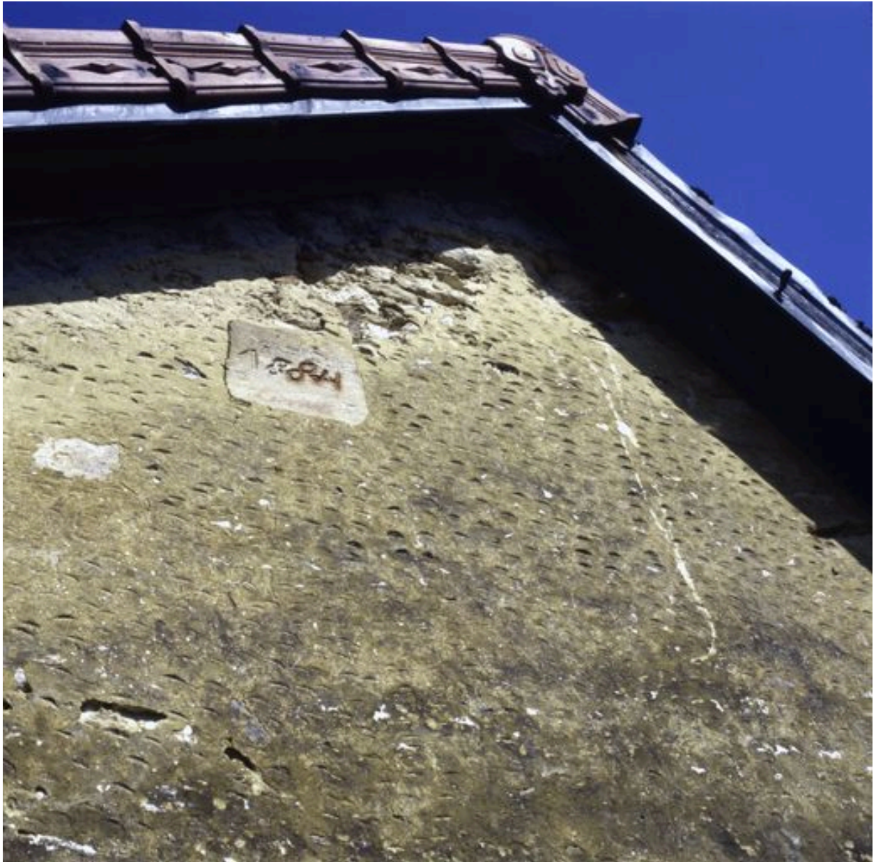
Détail de la date de 1884 gravée sur le pignon d'un des ateliers en shed.
