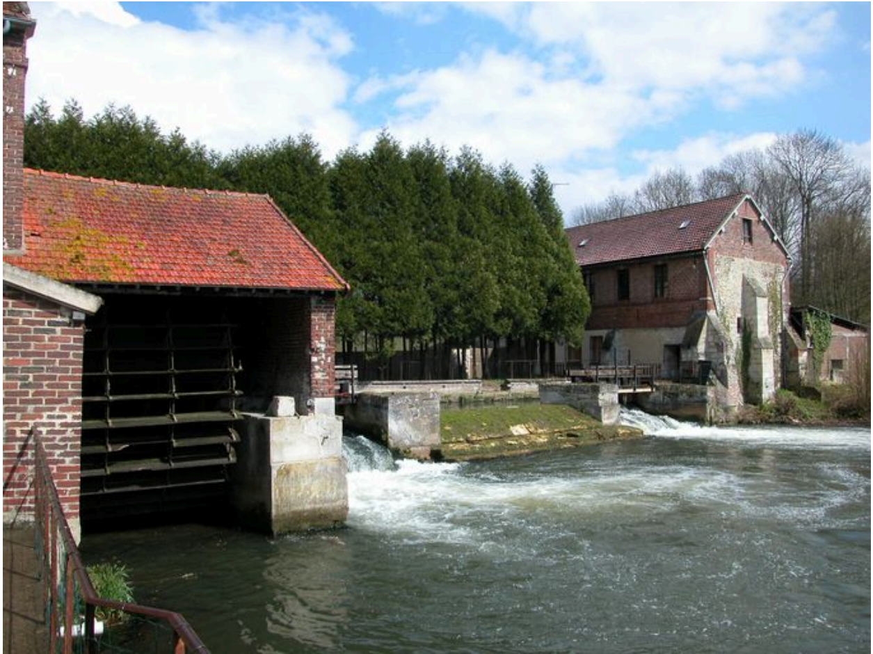
Vue d'ensemble du moulin d'Achon et de la cage de la roue du second moulin.
