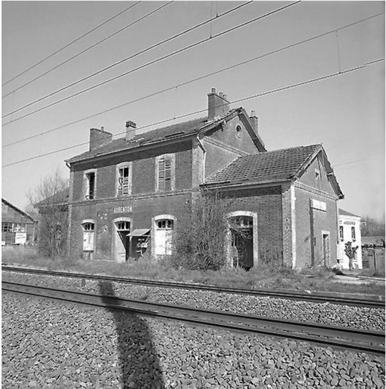
Elévation postérieure depuis la voie.
