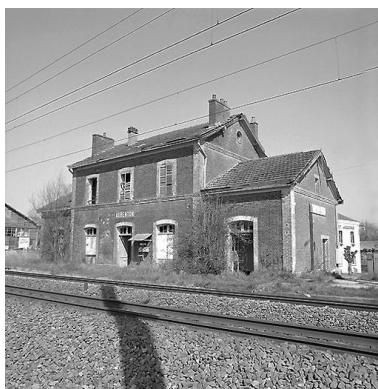
Élévation postérieure depuis la voie. Phot. Thierry Lefébure IVR22_20020200289X
