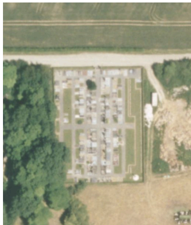
Vue aérienne. Phot. Phot. Inv. IVR22_20058010434NUCA
