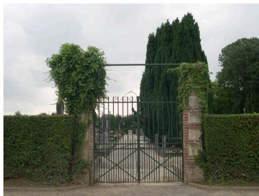
Vue du portail. Phot. Isabelle Barbedor IVR22_20068010084NUCA
