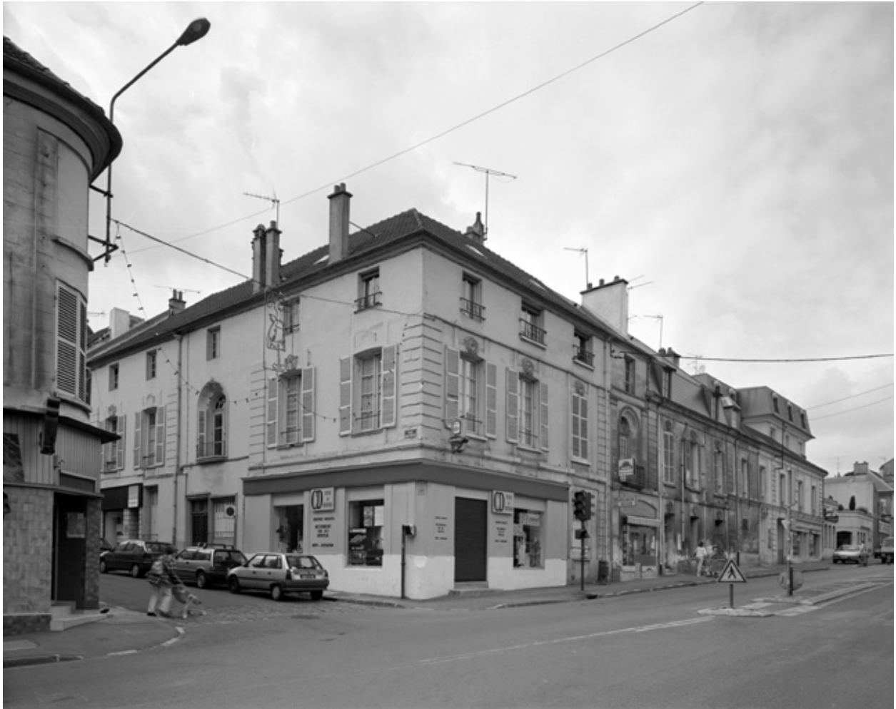
Vue de la façade sur l'avenue de Soissons et de l'angle des deux rues.
