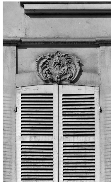
Détail d'une clé de fenêtre. Phot. Thierry Lefébure IVR22_19950203326V
