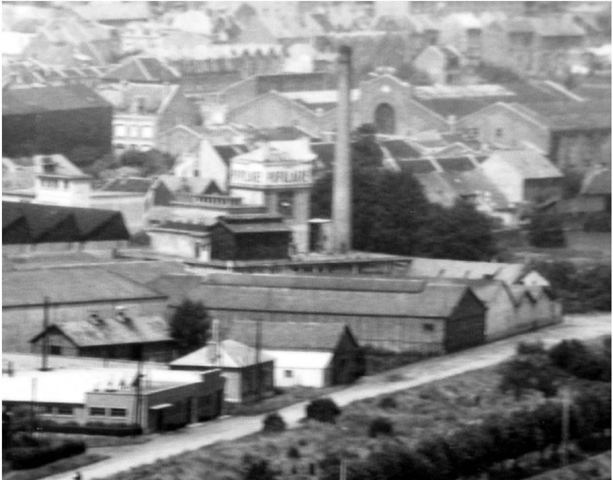
La brasserie photographiée du sud-ouest entre 1950 et 1964. A l'arrière-plan, les trois halles des ateliers de construction D'Hennezel & Cardon (AD Aisne).
