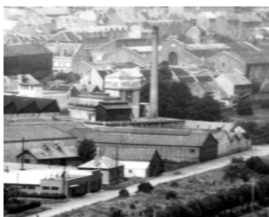
La brasserie photographiée du sud-ouest entre 1950 et 1964. A l'arrière-plan, les trois halles des ateliers de construction D'Hennezel & Cardon (AD Aisne).
