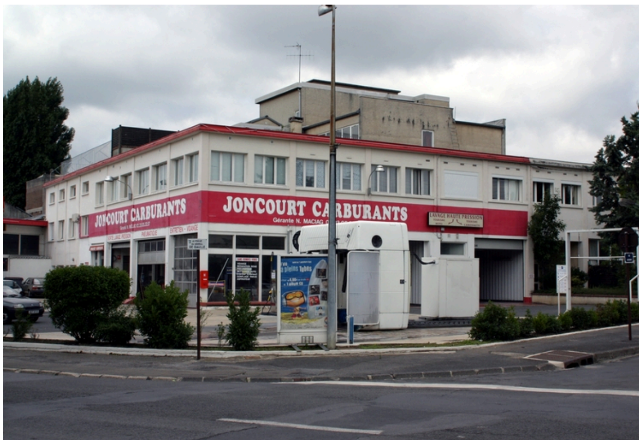
L'ancienne brasserie, à l'angle de la rue Jacquard et de l'avenue du Général-de-Gaulle.
