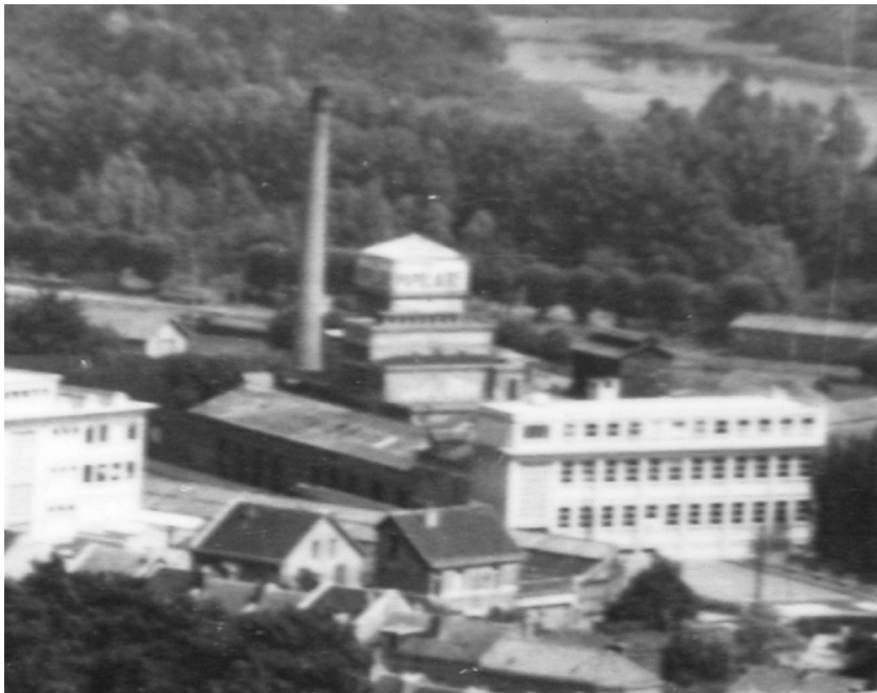
Vue aérienne de la brasserie prise du nord-ouest, entre 1950 et 1964. Au premier plan, les Etablissements Métallurgiques Boyer (AD Aisne).
