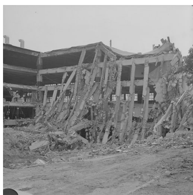
Vue d'ensemble du garage en cours de démolition, le 26 avril 1999. Phot. Thierry Lefébure IVR22_19998000921X
