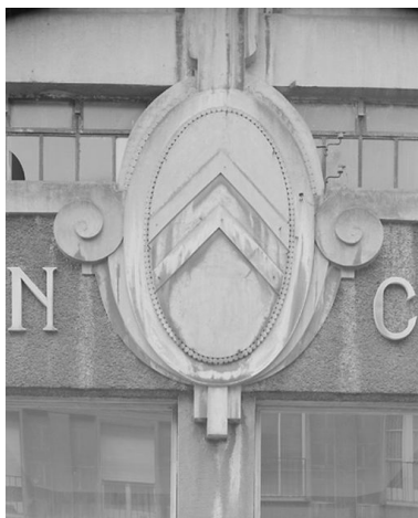
Détail du médaillon portant le sigle Citroën et ornant l'ancienne entrée principale sur la façade. Phot. Irwin Leullier IVR22_19978001056V
