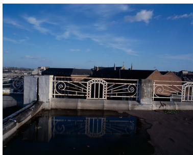
Détail de la balustrade bordant la terrasse. Phot. Thierry Lefébure IVR22_19988001231XA
