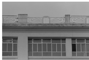
Détail de la balustrade bordant la terrasse. Phot. Thierry Lefébure IVR22_19978001054X
