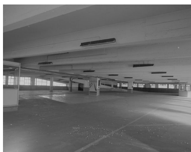
Vue d'ensemble du niveau 1. Phot. Irwin Leullier IVR22_19988001204X
