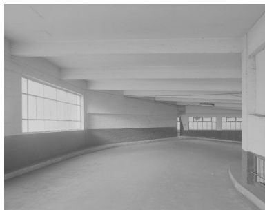
Vue d'une partie de la rampe d'accès entre le niveau 2 et le niveau 3. Phot. Thierry Lefébure IVR22_19988001218X
