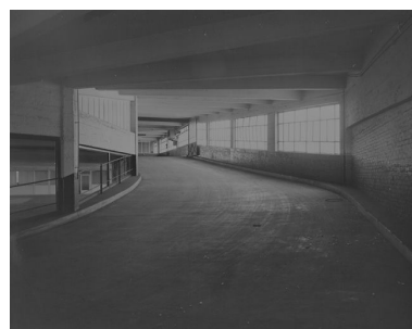
Vue d'ensemble de la rampe d'accès entre le niveau 2 et le niveau 3. Phot. Thierry Lefébure IVR22_19988001212X
