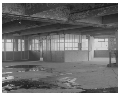
Vue d'une partie des bureaux au niveau 3. Phot. Thierry Lefébure IVR22_19988001217X
