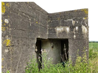
Entrées, sud Phot. Jean-Marc Ramette IVR31_20145904475NUCA
