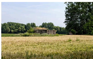
Vue de trois-quarts, vers le nord-est Phot. Jean-Marc Ramette IVR31_20145904472NUCA
