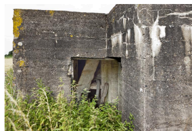
Entrées sud Phot. Jean-Marc Ramette IVR31_20145904474NUCA
