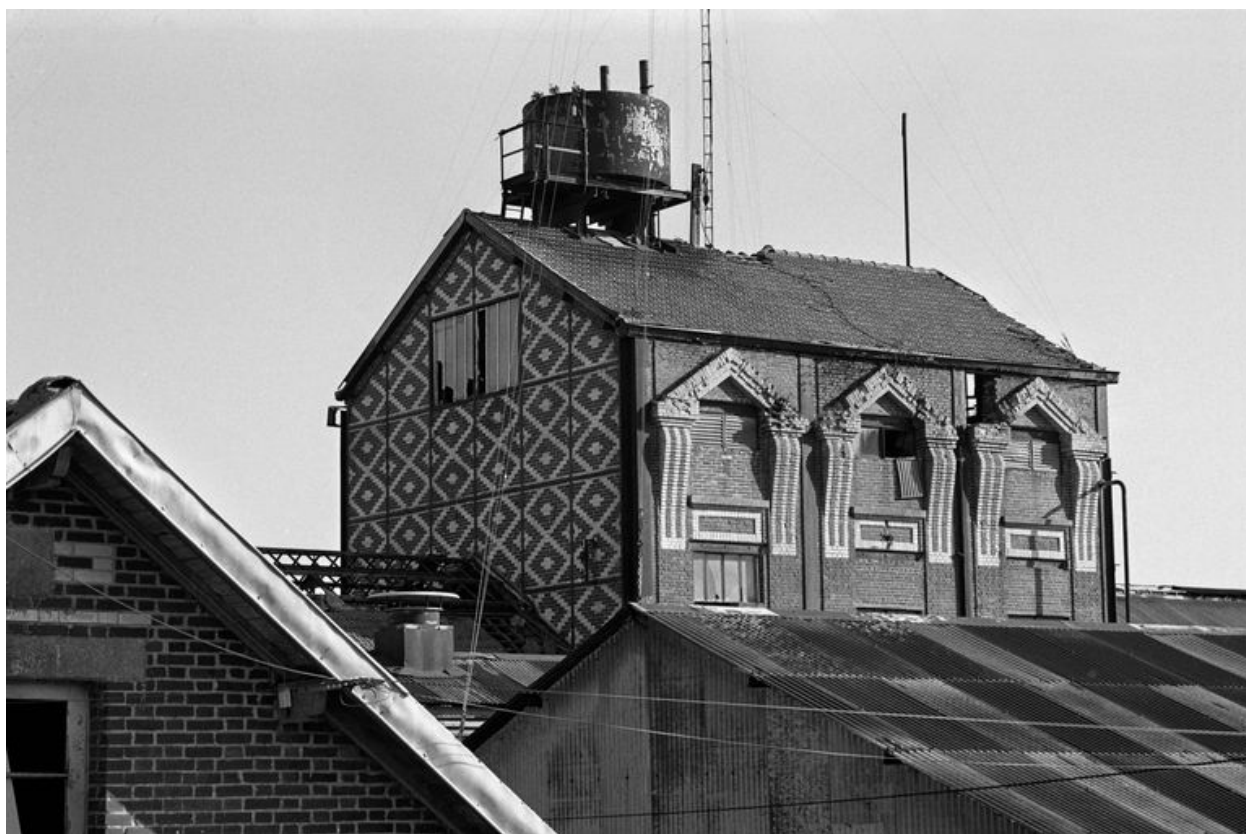
Atelier de fabrication principal : flanc nord-ouest.
