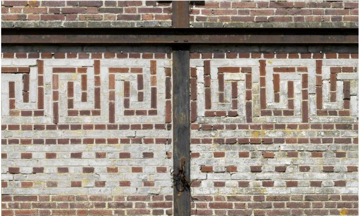
Détail de la frise décorative qui orne le pignon de l'atelier de fabrication.
