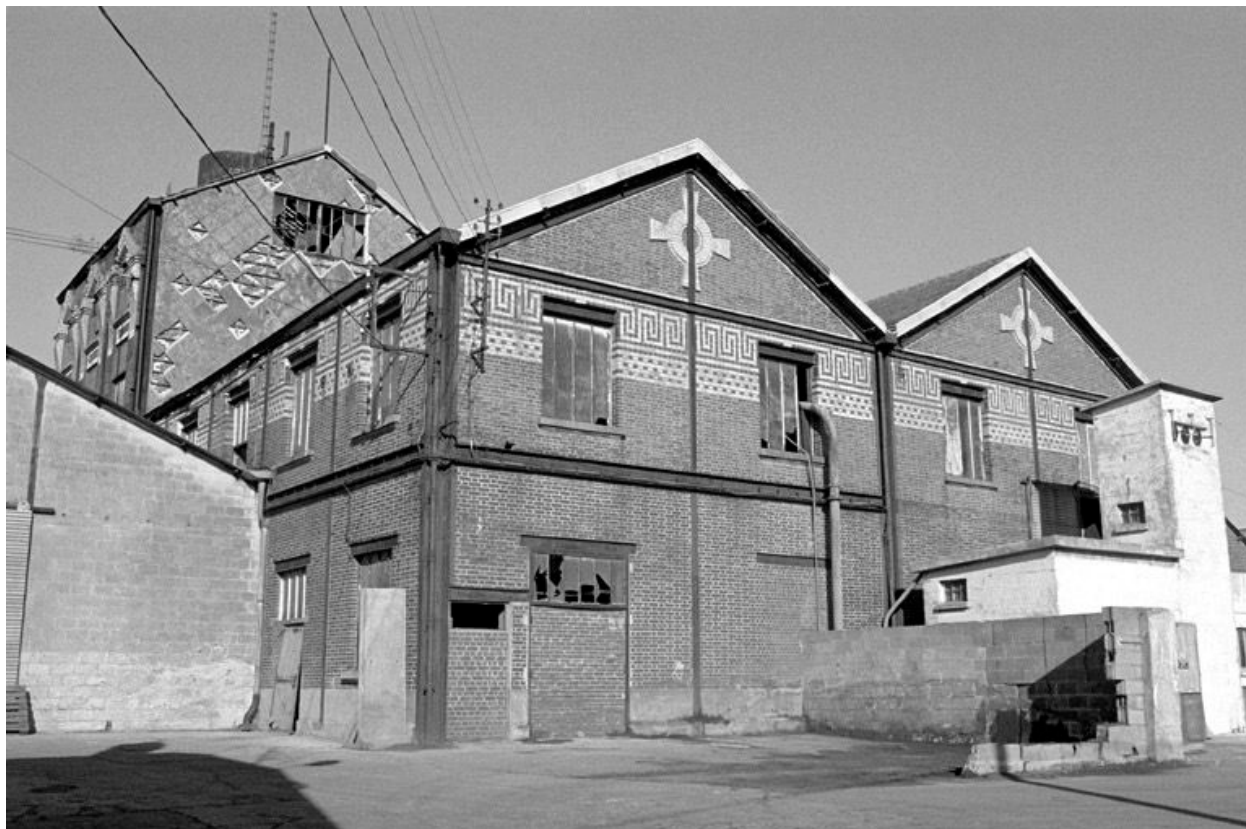
Atelier de fabrication, vue d'ensemble.
