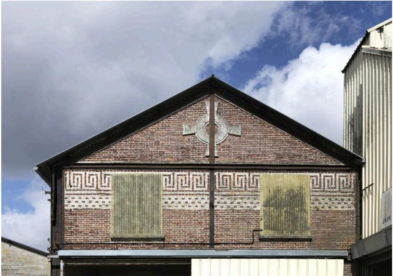
Détail de la partie supérieure d'un pignon des ateliers de fabrication.
