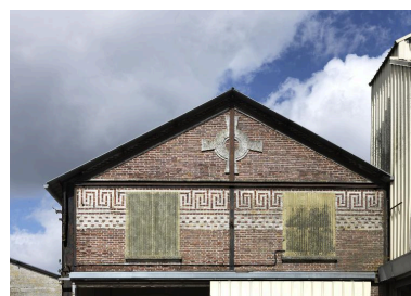
Détail de la partie supérieure d'un pignon des ateliers de fabrication. Phot. Thierry Lefébure IVR22_20158000169NUC2A
