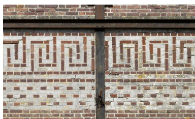
Détail de la frise décorative qui orne le pignon de l'atelier de fabrication. Phot. Thierry Lefébure IVR22_20158000170NUC2A
