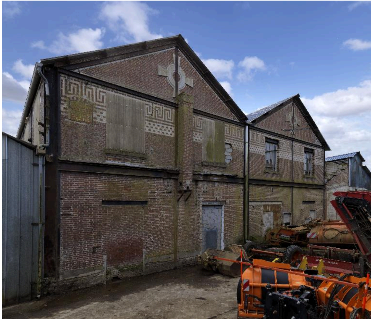
Vue d'ensemble des façades postérieures des ateliers de fabrication.
