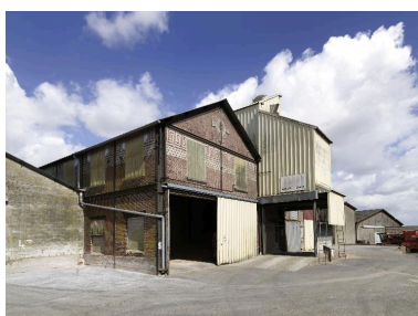
Vue d'ensemble de trois- quarts de l'atelier de fabrication. Phot. Thierry Lefébure IVR22_20158000167NUC2A
