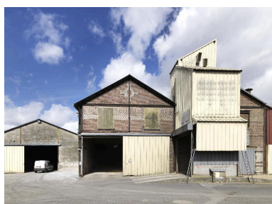
Vue d'ensemble des pignons sur cour des ateliers de fabrication. Phot. Thierry Lefébure IVR22_20158000168NUC2A
