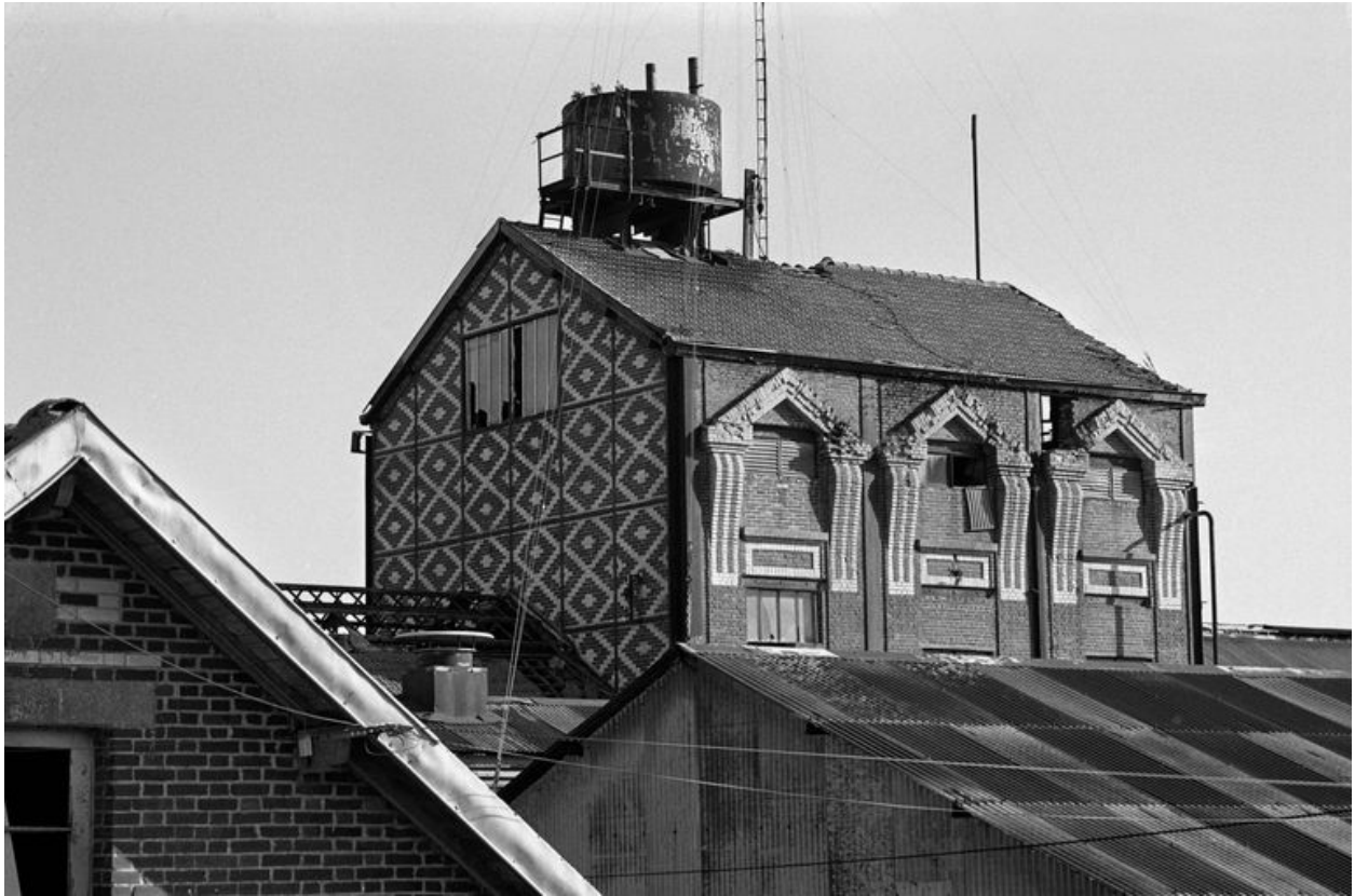
Atelier de fabrication principal : flanc nord-ouest.
