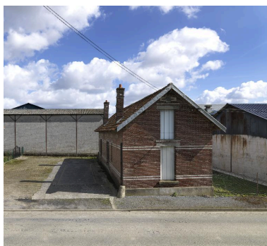
Bureau de pesée avec sa bascule à l'ancienne entrée de l'usine. Phot. Thierry Lefébure IVR22_20158000176NUC2A
