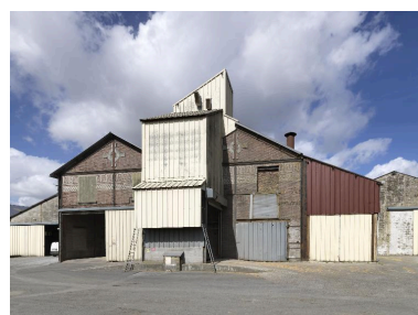
Vue d'ensemble des pignons des ateliers de fabrication. Phot. Thierry Lefébure IVR22_20158000171NUC2AQ
