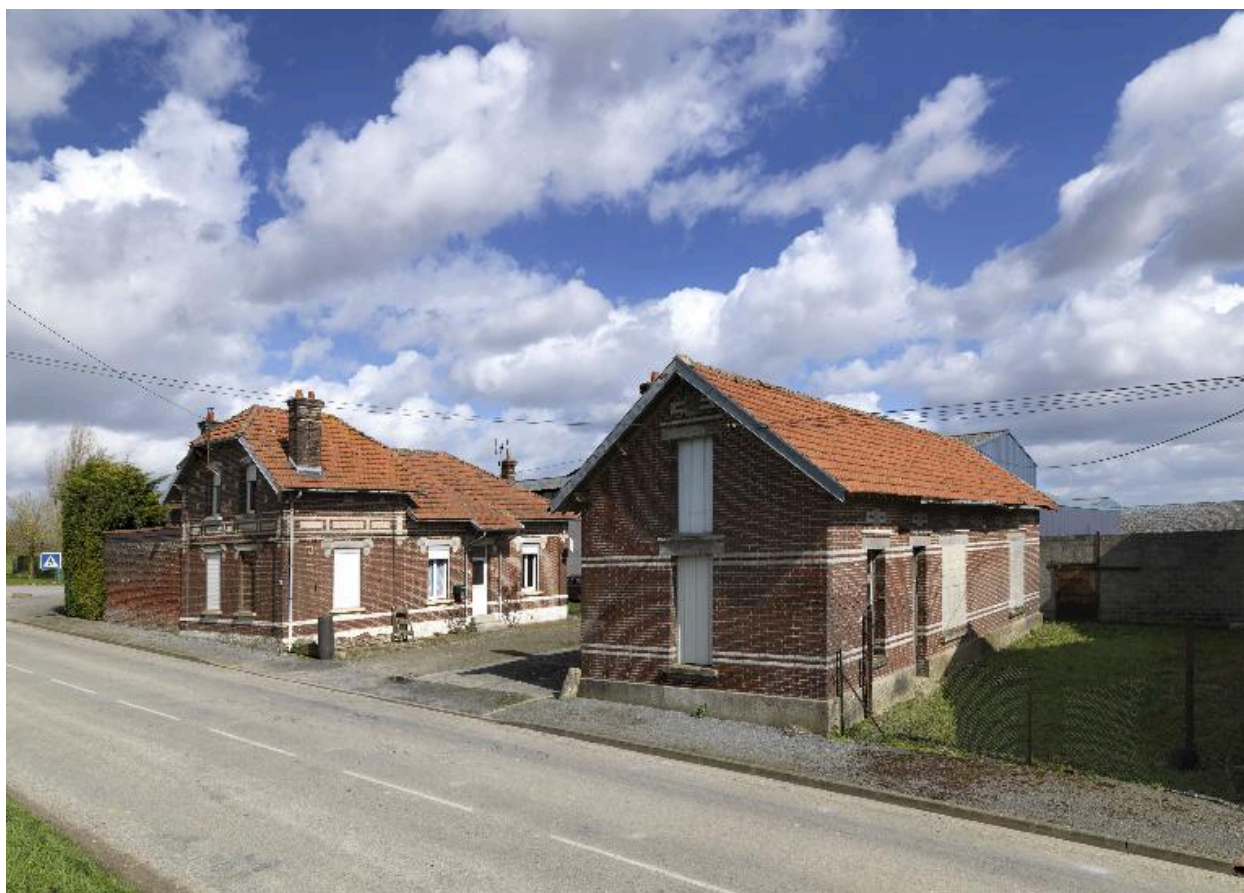
Logement de contremaître et bureau de pesée.
