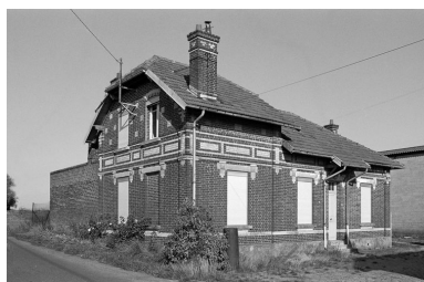
Logement de contremaître : flanc sud-ouest. Phot. Francis Dubuc IVR22_19908001116Z
