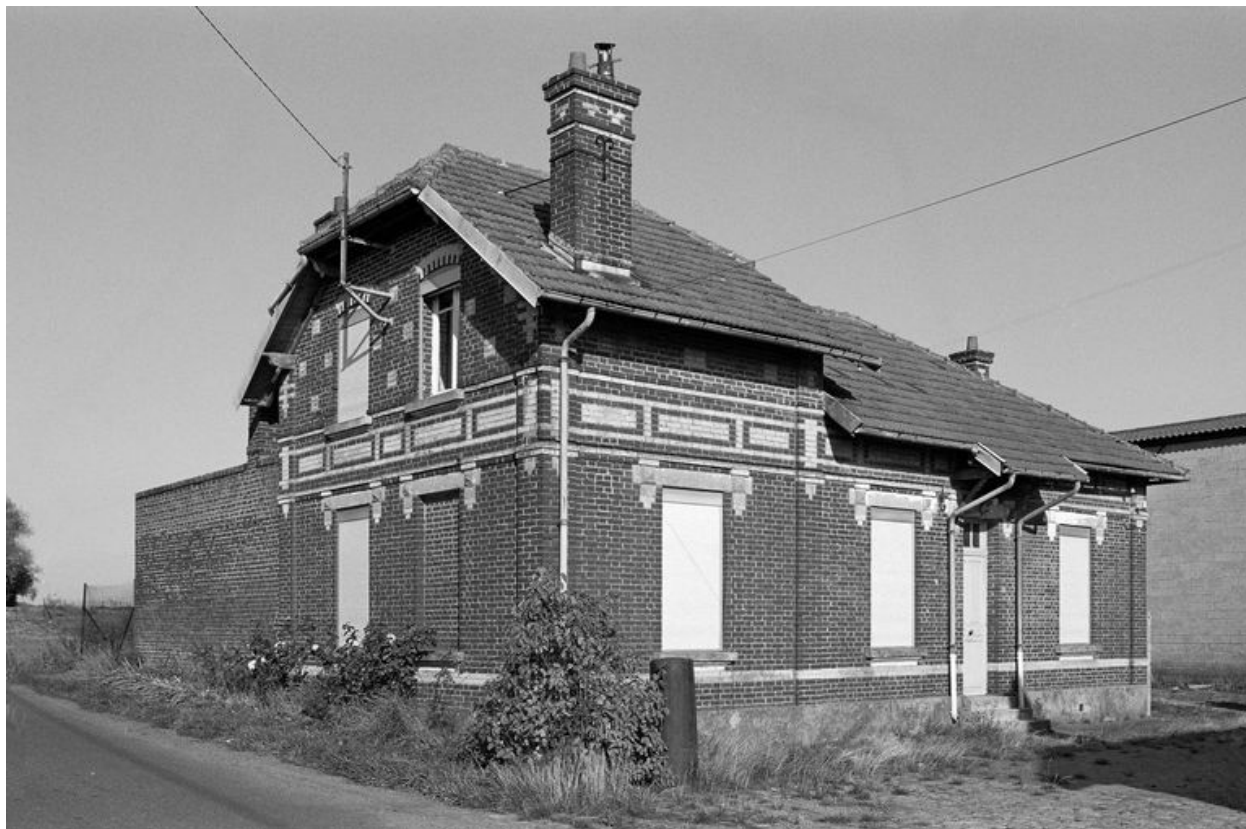
Logement de contremaître : flanc sud-ouest.
