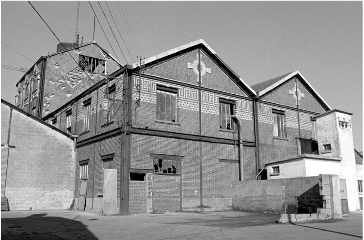
Atelier de fabrication, vue d'ensemble.
