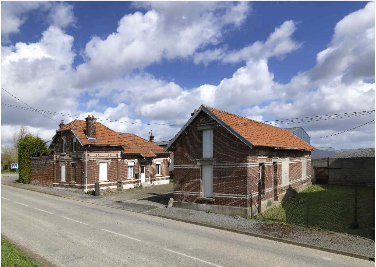
Logement de contremaître et bureau de pesée.
