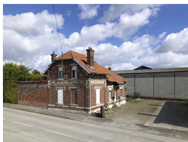
Logement de contremaître à l'ancienne entrée de l'usine. Phot. Thierry Lefébure IVR22_20158000175NUC2A
