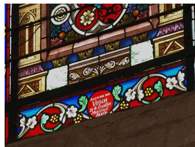
Baie 0 : inscription de restauration en partie basse de la lancette Phot. Bruno Decrock IVR31_20106202934NUCA
